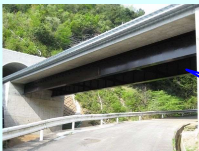
ハタボキ谷橋(2008年竣工)
