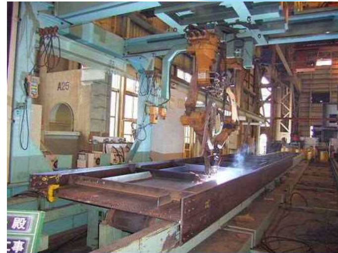
補剛材本溶接(多関節Co2溶接ロボット)
