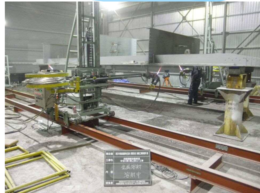
自動機による施工状況
