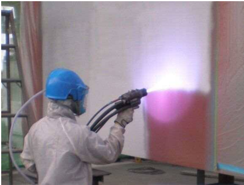
溶射技能士による施工状況
