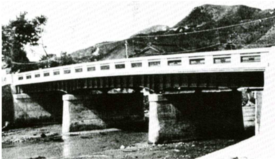
初の完全溶込み溶接継手を取り入れた 恵川橋(1949年)
