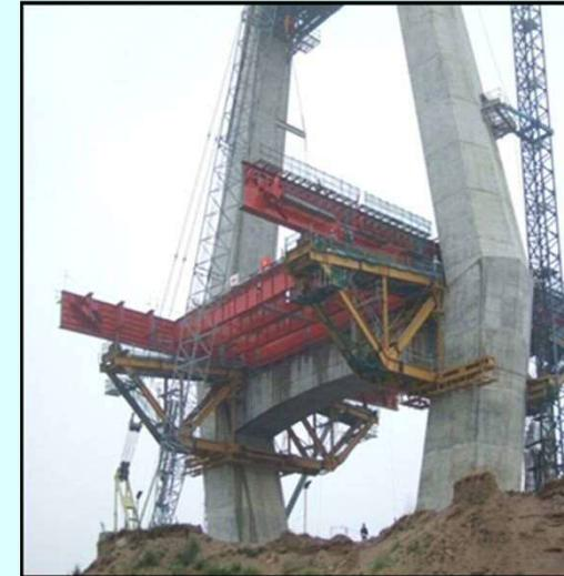
主桁、横桁架設
