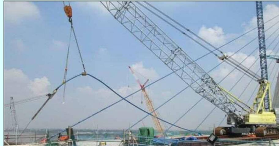
ステイケーブルの架設(桁側)
