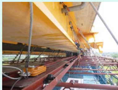
部材移動用レール設置状況
