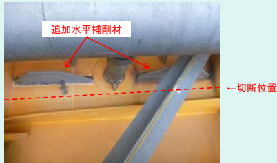
追加水平補剛材設置状況
