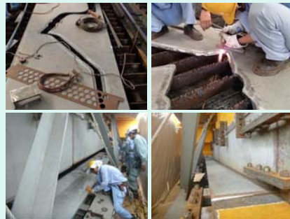
新設部材製作、設置状況
