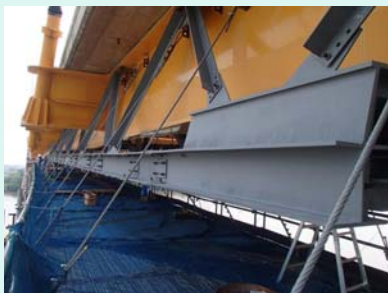
バイパストラス設置状況(施工中)
