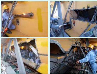
桁切断・開先加工状況
