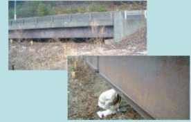
閉塞的空間事例(桁下空間不足)
