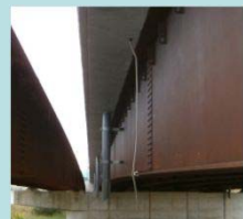
排水流末を桁下まで十分伸ばした例
