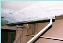
床版漏水の応急処置事例
