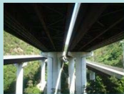
凍結防止剤散布路線の並列橋
