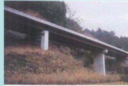
閉塞的空間事例(地山近接)
