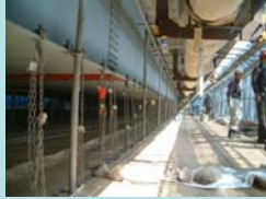
補修塗装事例
