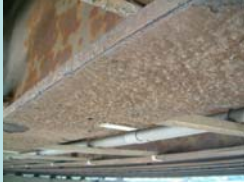
飛来塩分による損傷
