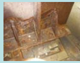
伸縮装置からの漏水による腐食
