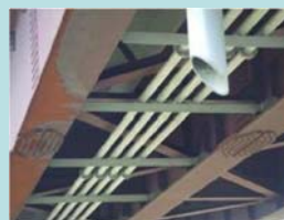
排水流末からの飛散による腐食
