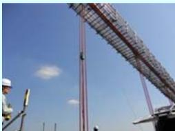
写真1 全磁束法測定状況(右:磁化機)
