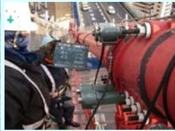
写真2 ケーブルバンドボルト取替状況
