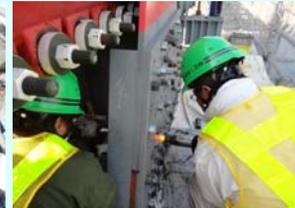
写真4 リベット打ち込み
