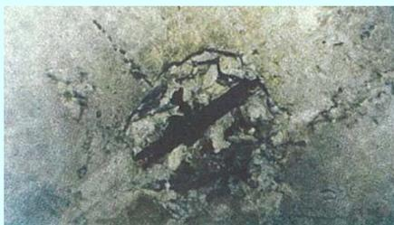
床版下面のコンクリートの抜け落ち
