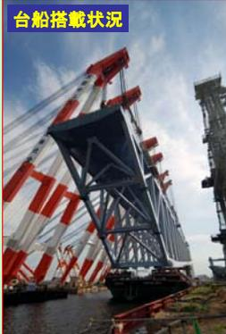
台船搭載時、約9,000tのバラストを使用し台船の変形を調整
