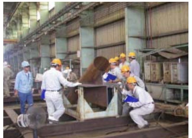
写真-2 ケーブル定着部の溶接施工試験状況
