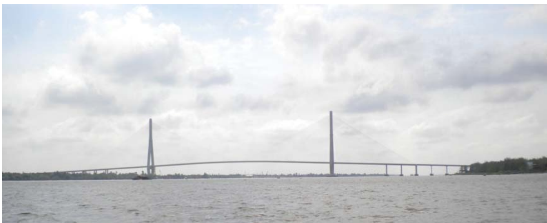
写真-14 完成されたカントー橋（ハウ川から撮影）
