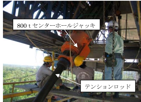
写真-13 桁下からのケーブルの引込み
