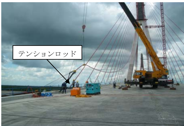
写真-12 定着部へのケーブルの挿入
