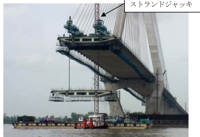
写真-10 鋼桁セグメントの直下吊り状況
