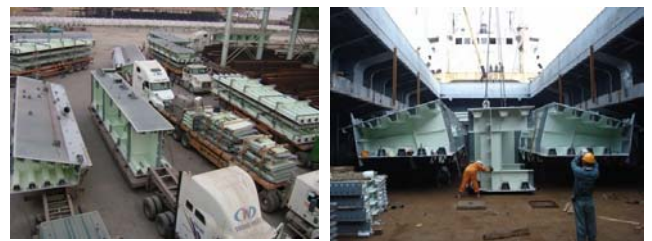
(トレーラーへの積付け) (輸送船内の積付け)
