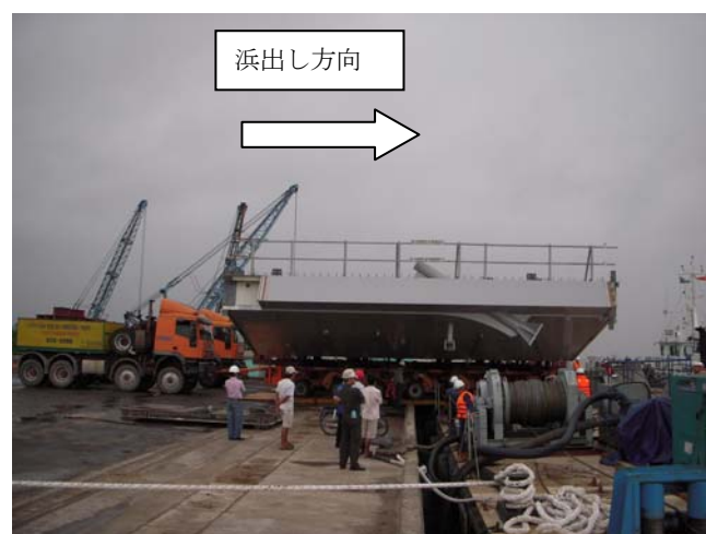
写真-8 鋼桁セグメントの浜出し状況
