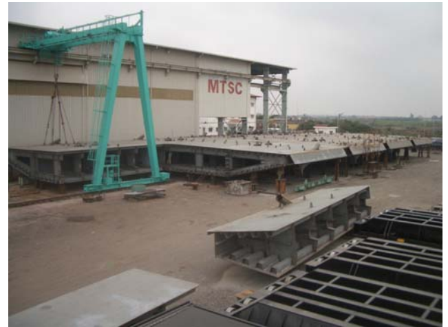
写真-4 鋼桁の仮組立状況
