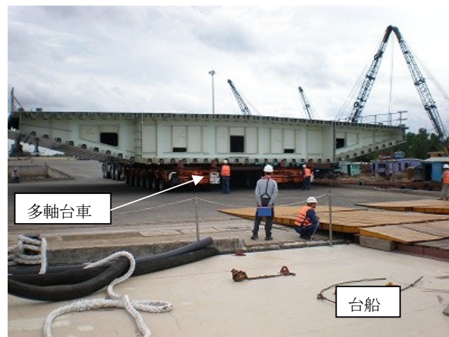
写真-7 鋼桁セグメントを搭載した多軸台車
