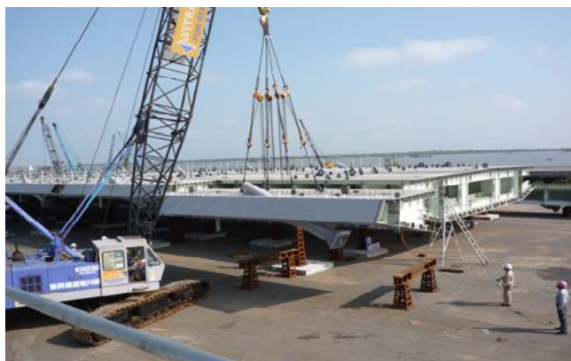
写真-6 カイクイ港での地組立状況
