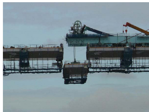
写真-11 閉合桁の吊上げ
