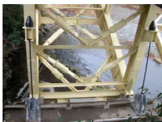
写真-12 端支柱部座屈 拘束ブレース
