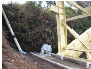
写真-13 アップリフト 止め
