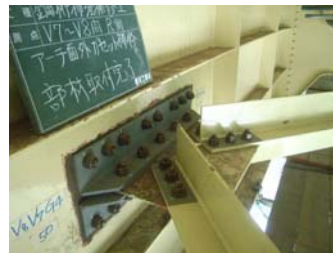
写真-9 横構ガセット補強
