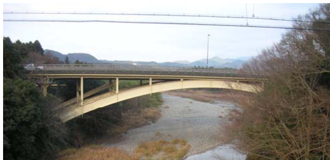
写真-1 全景写真
