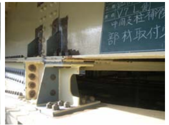
写真-8 中間支柱補強リブ
