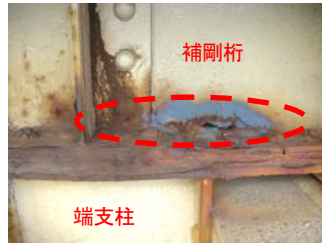
写真-2 端支柱天端
