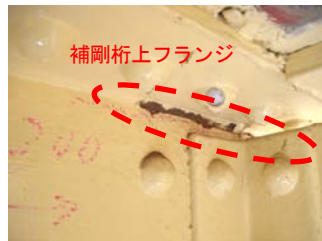
写真-4 補剛桁溶接部
