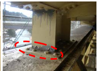
写真-5 中間支柱
