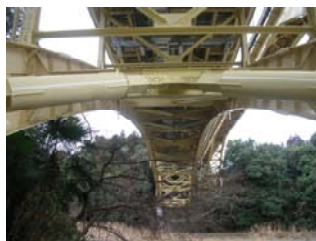
写真-11 アーチ横構部 座屈拘束ブレース
