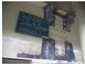
写真-7 補剛桁補強リブ
