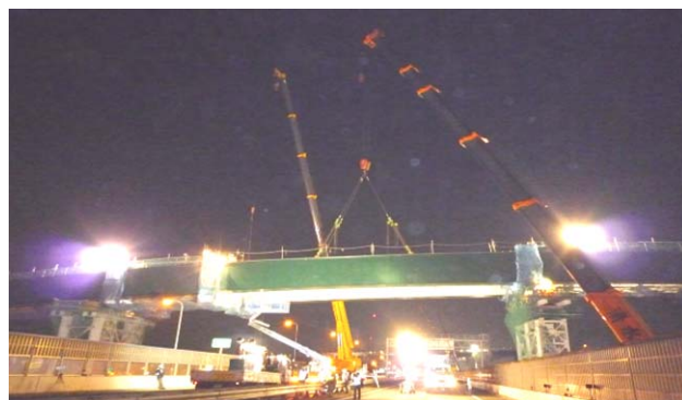
写真-6 近畿自動車道上空架設(Aランプ橋)
