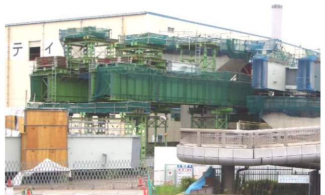
写真-11 BP9 橋脚ベント
