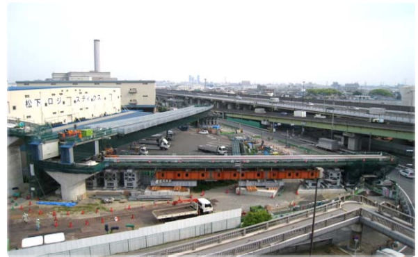
写真-2 回転横取り施工後
