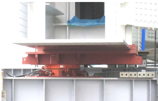
写真-3 回転中心設備
