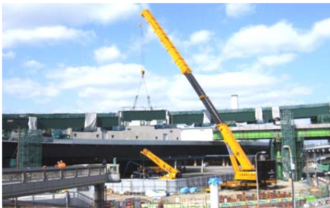
写真-10 BP9～10 橋脚間落とし込み架設
