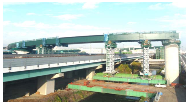
写真-8 近畿道上空架設完了(Aランプ橋)
