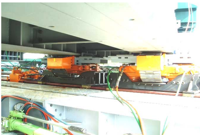
写真-5 2軸スライド装置配置
