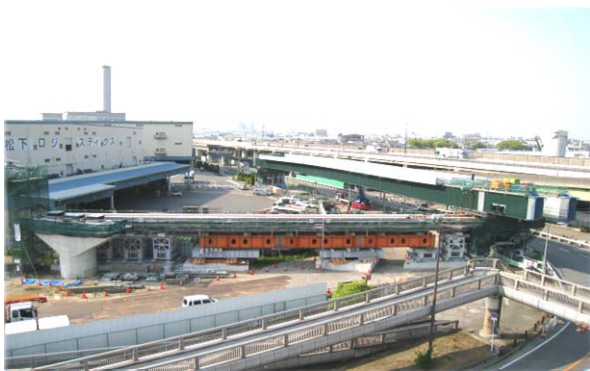
写真-1 回転横取り施工前
