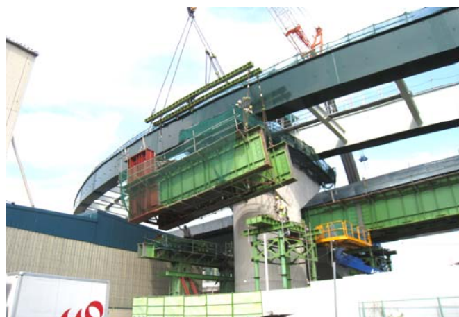
写真-15 吊り天秤を使用した大型ベントの解体
