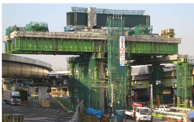
写真-12 BP10 橋脚ベント
