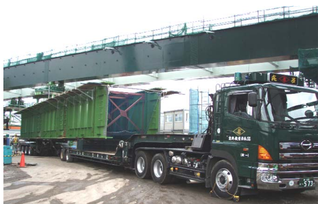
写真-13 ブロック化した部材の運搬
