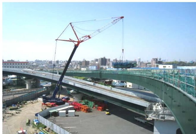
写真-14 大型ベントの解体全景
