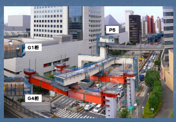
G4桁の張出架設2
