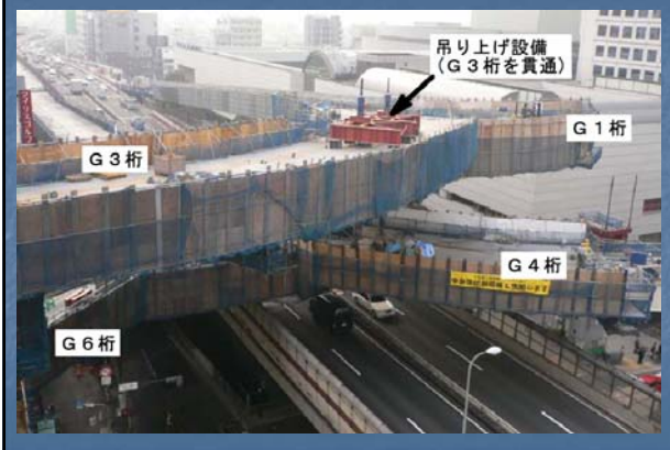
G4桁の張出架設1
