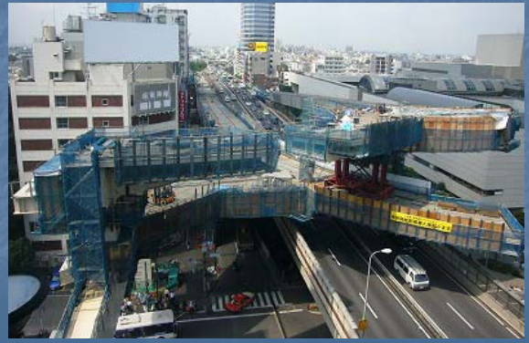
G3桁の張出架設2
