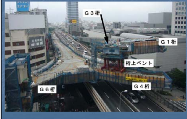
G3桁の張出架設1
