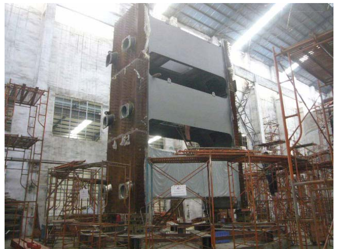
写真-4.2 アンカーボックス仮組立
