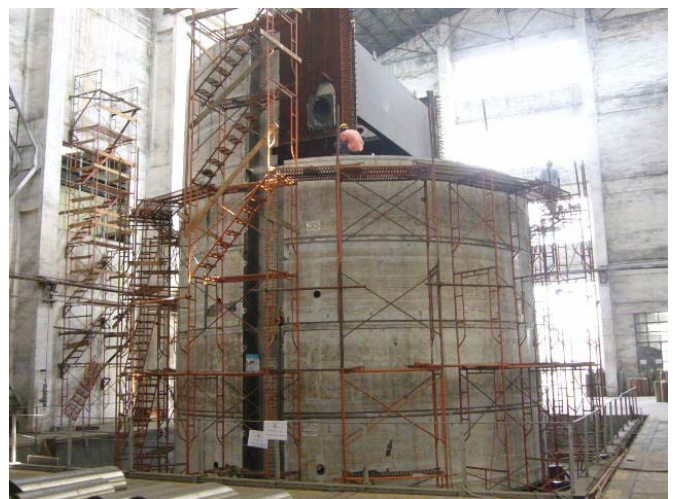
写真-4.3 ステンレススキン及びアンカーボックス仮組立
