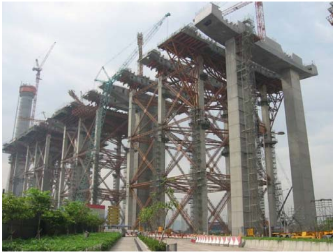
写真-5. 1 コンクリート桁の支保工
