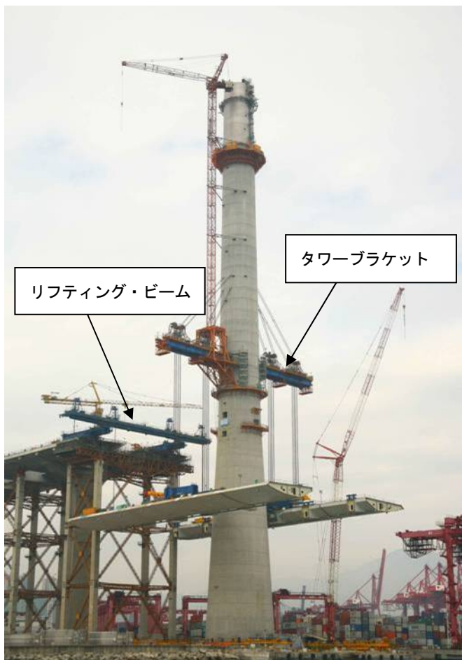
写真-6.2 一括吊上げ状況
