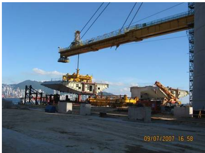
写真-6.1 ブロックの水切り状況
