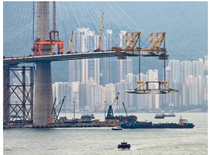
写真－7. 2 主桁セグメントの架設
