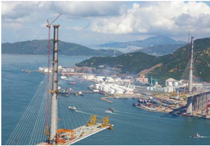
写真－7. 1 張出し架設中の全景
