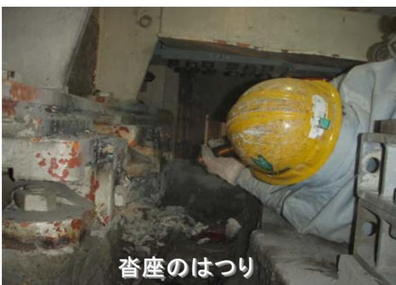
写真-4.1 補修現場での施工状況
