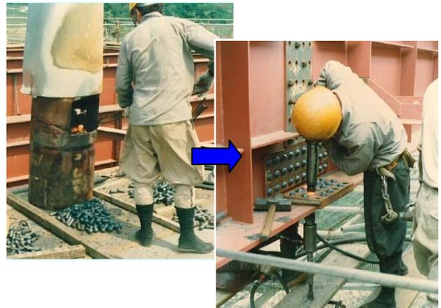
写真-2.13 リベットの施工
