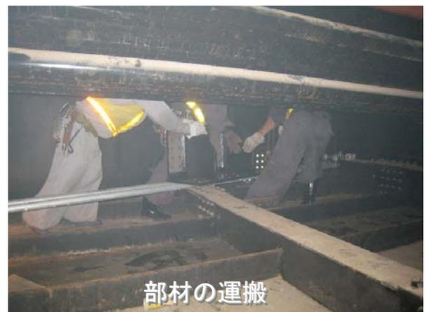
写真-4.2 部材の人力運搬
