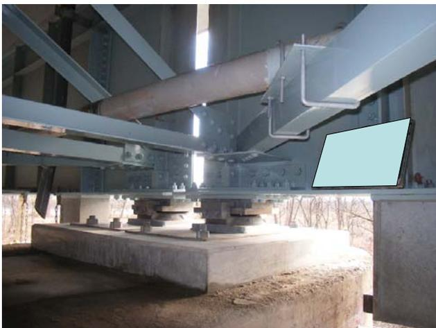
写真-2.12 一体型台座の施工例
