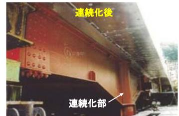
写真-2.19 ゲルバー構造部の補強例
