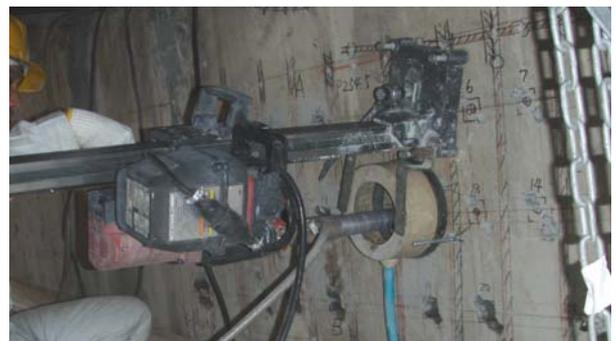
写真-4.5 ダイヤモンドコアドリルによる削孔
