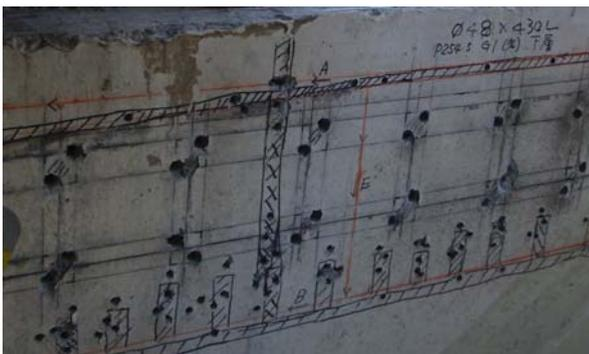
写真-4.4 パイロットホールによる鉄筋確認
