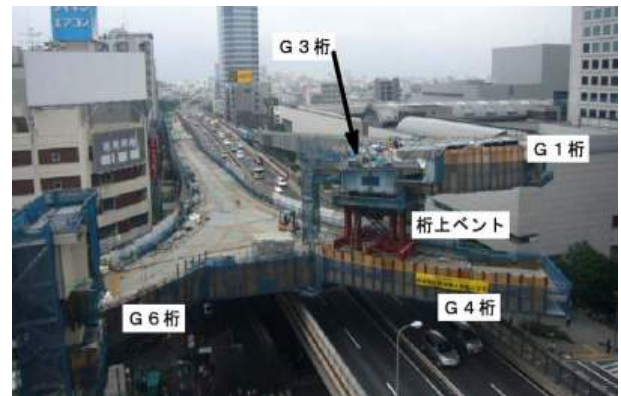
写真-7 桁上ベント (G4桁でG3桁を支持)
