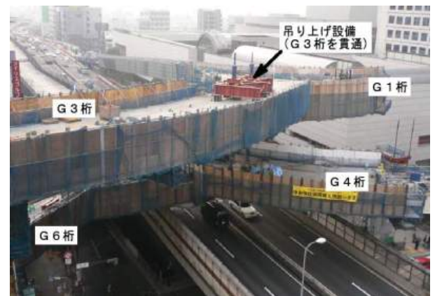
写真-8 桁上吊り上げ設備 (G3桁からG4桁を吊り上げ)
