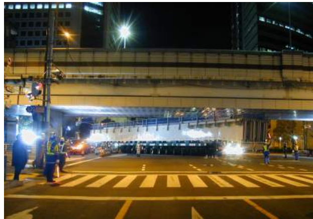
写真-5 多軸台車による上部工大ブロックの搬入
