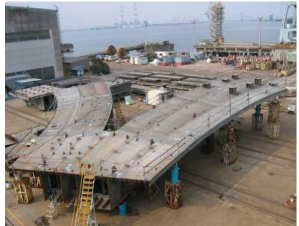
写真-2 主桁分岐部仮組立
