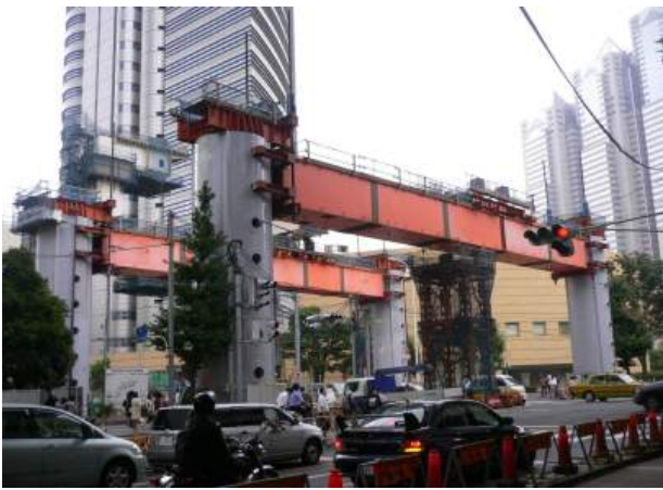
写真－ 10 曲線部上部工一括架設
