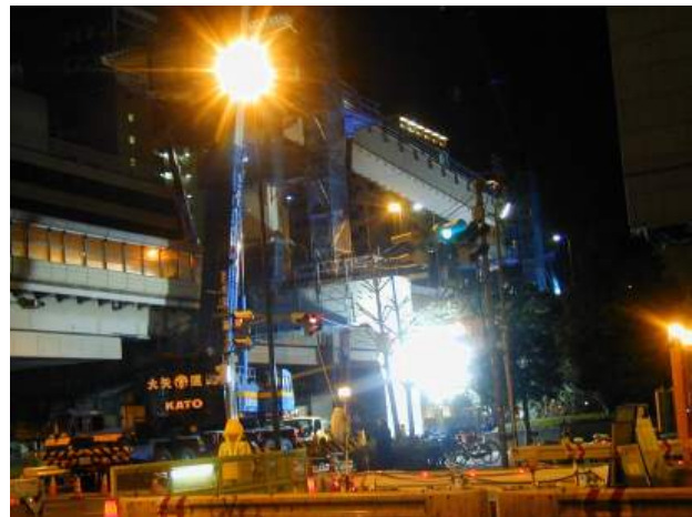
写真-6 相吊りによる大ブロック一括架設
