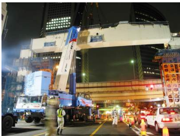
写真-4 P4 橋脚横梁一括架設
