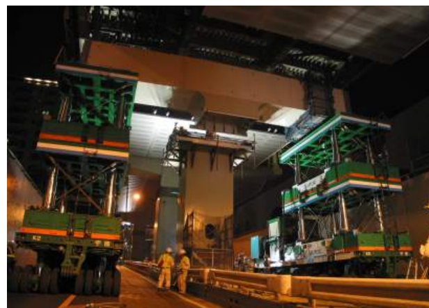
写真-3 多軸台車とテーブルリフターによる横梁架設
