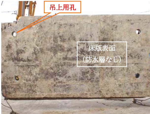
写真-13 コンクリート表面の状況
