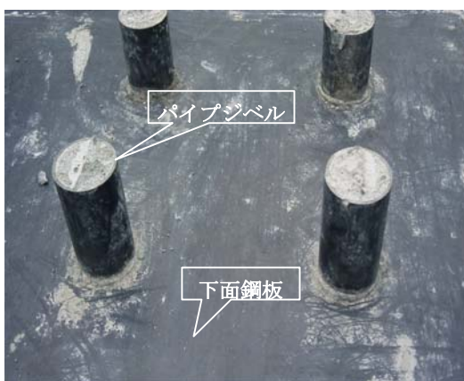
写真-19 パイプジベルの状況
