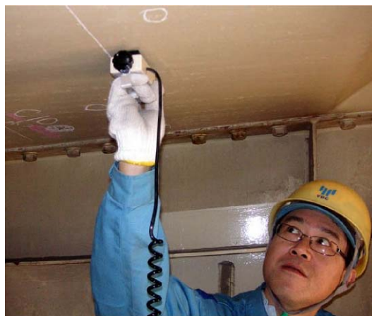
写真-6 弾性スイープ波法の調査状況
