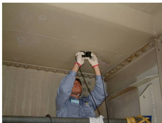
写真-8 超音波法の調査状況
