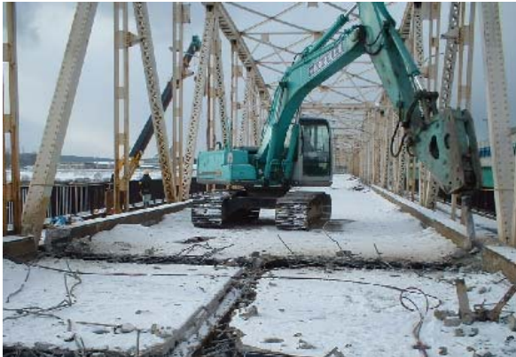
写真-11 旧秋田大橋の床版撤去状況
