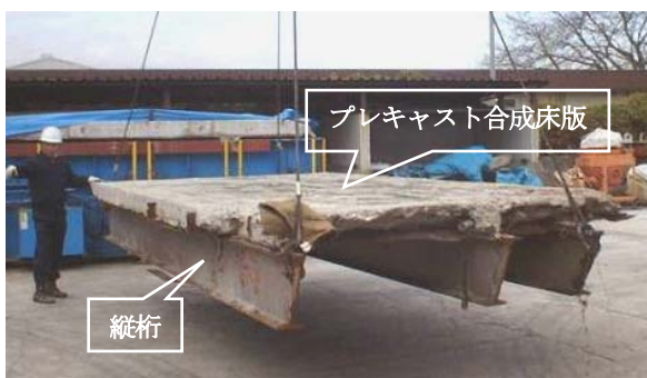
写真-12 切出した合成床版の状況
