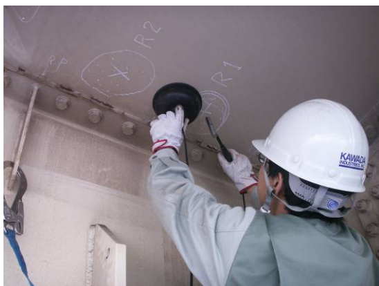
写真-4 打音法の調査状況
