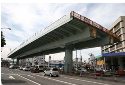
写真-11 一括移動架設直後の小坂交差点
