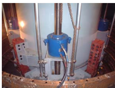
写真-10 橋脚基部の連結部
