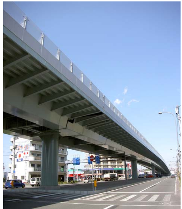
写真-13 完成写真
