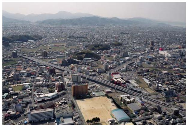
写真-14 完成航空写真
