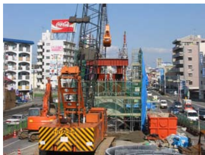
写真-1 オープンケーソンの圧入掘削
