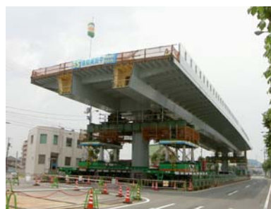
写真-7 地組立完了(ドーリーで支持)
