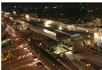
写真-8 ドーリーによる一括移動架設
