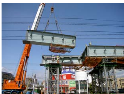
写真-5 上部工の地組立
