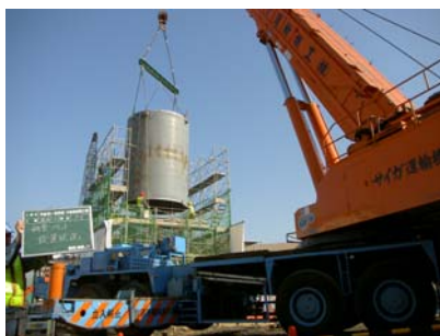
写真-2 ソケット鋼管の設置
