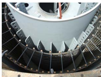
写真-3 橋脚第1節設置
