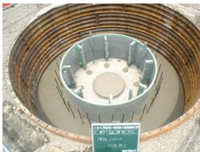
写真-4 環状コンクリート打込み完了
