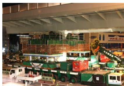
写真-9 ジャッキダウン
