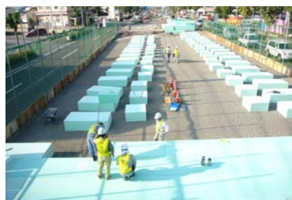
写真-12 EPS軽量盛土の施工
