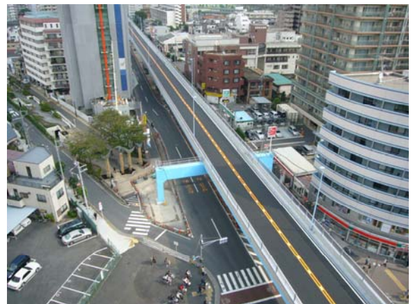
写真-23 新小岩陸橋完成
