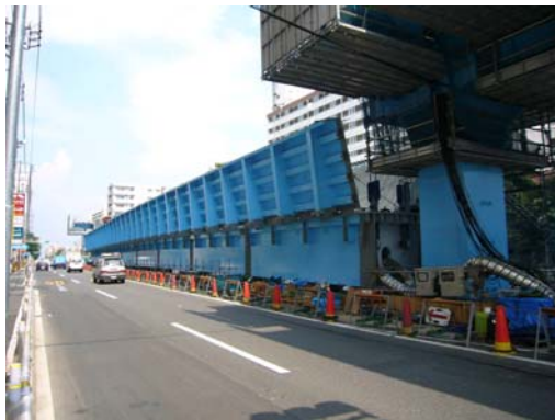
写真-9 桁組立状況(常設作業帯)
