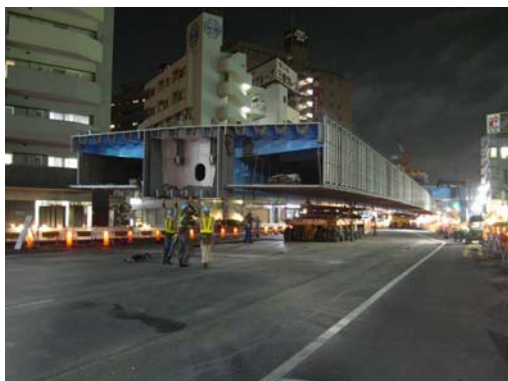
写真-14 鋼桁運搬状況
