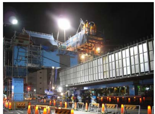
写真-15 吊上げ状況(交差点部)
