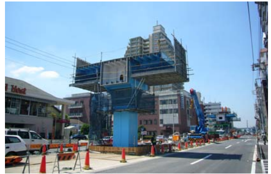
写真-8 橋脚柱部架設状況
