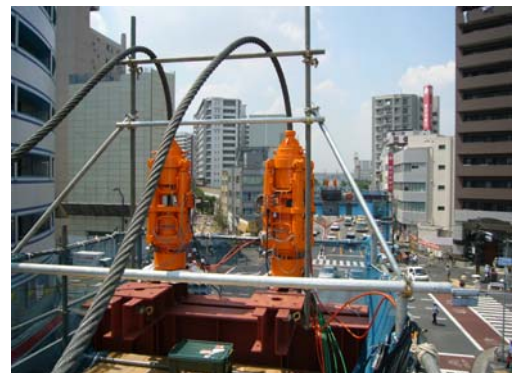
写真-13 橋柱頭部吊上げ設備
