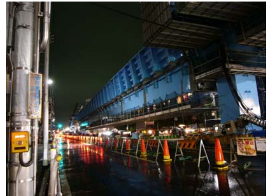
写真-10 桁吊上げ状況(1車規制)
