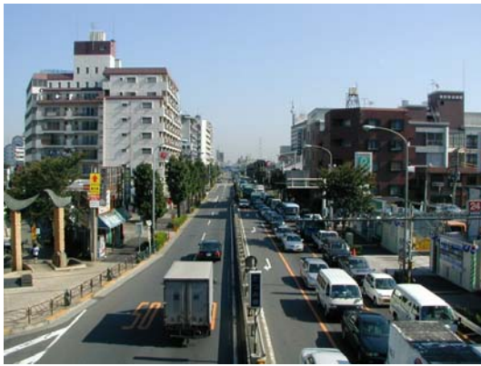
写真-1 蔵前橋通り(施工前)
