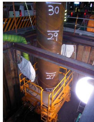
写真-7 SPACE21工法
