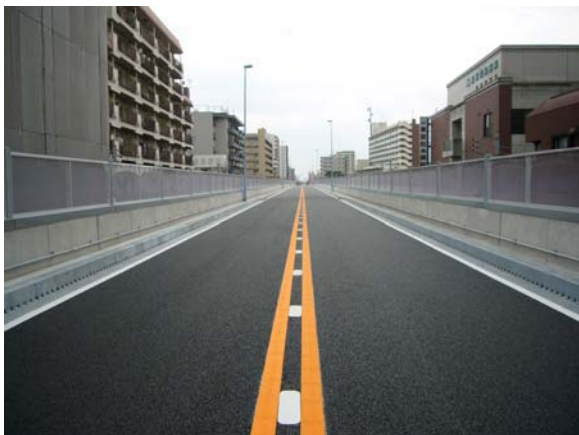
写真-21 橋面完成状況
