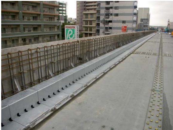
写真-20 橋面工施工状況
