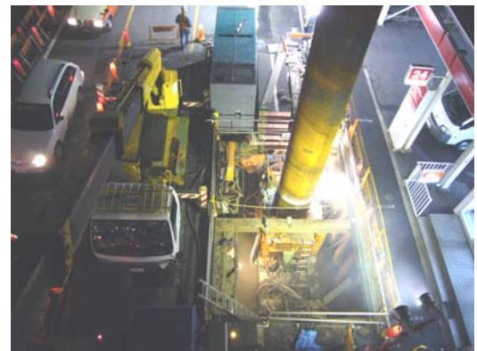
写真-6 交差点付近杭施工状況
