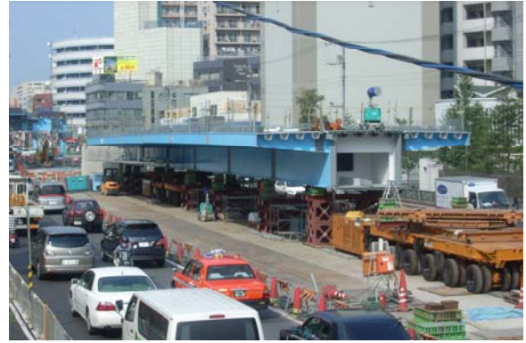
写真-11 A1背面組立ヤード
