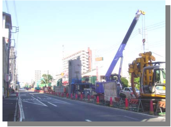
写真-5 場所打ち杭(TBH)
