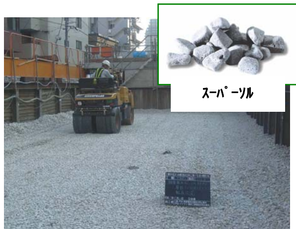
写真-19 軽量盛土材(アプローチ部)
