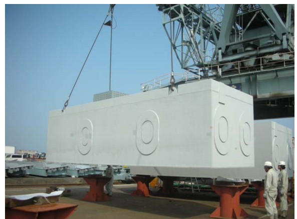
写真-2 鋼製フーチング
