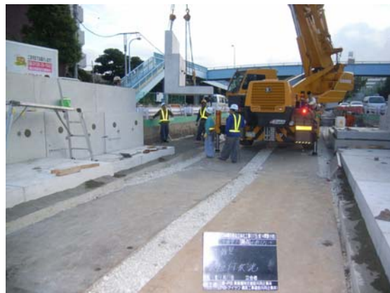
写真-17 L型擁壁(アプローチ部)
