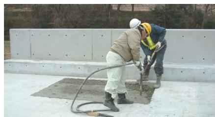
(d) 新コンクリートの締固め
