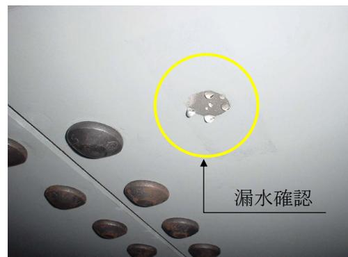
写真-6 先行モルタル施工による止水の例<sup>18)</sup>
