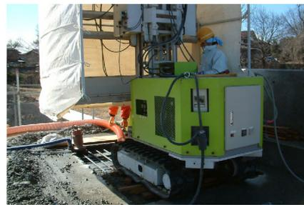
(a) ロボットによるはつり状況
