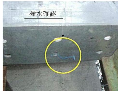
写真-5 樟腦を用いた止水栓の例<sup>17)</sup>
