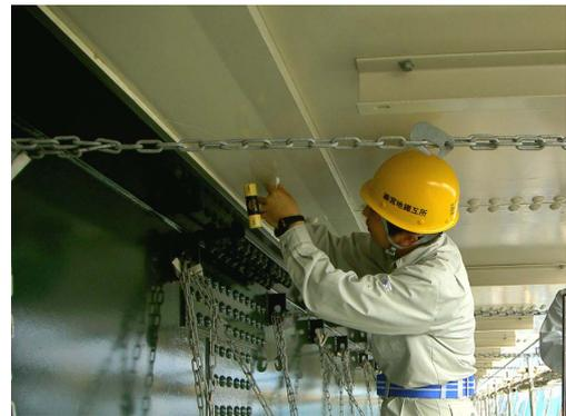
**写真-8 打音(たたき)試験**
