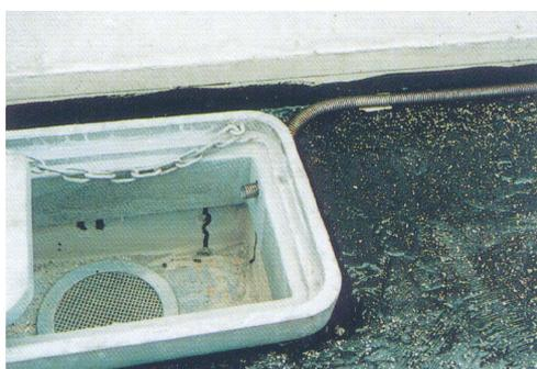
写真-3 舗装内導水管
