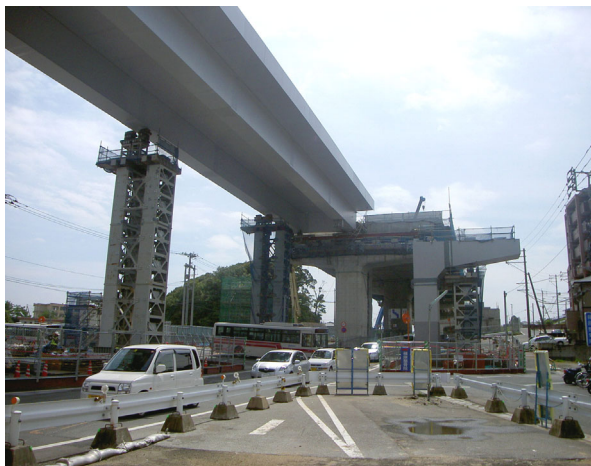
写真—2 架設状況 横取り前
