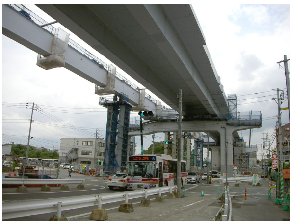
写真—3 架設状況 横取り完了
