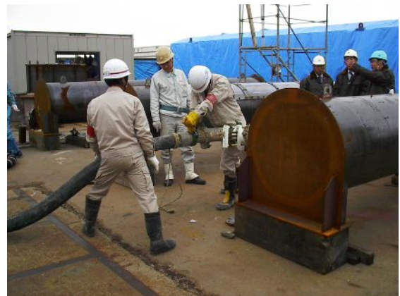
図-7 コンクリート充填状況
