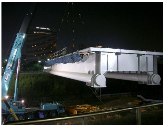
図-1 2 側径間の架設（一括架設）
