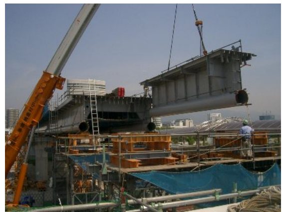
図-1 3 側径間の架設（単材架設）
