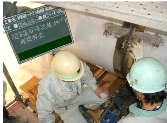
図-1 5 超音波探傷試験状況
