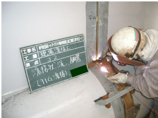
図-1 4 鋼管 TIG 溶接状況
