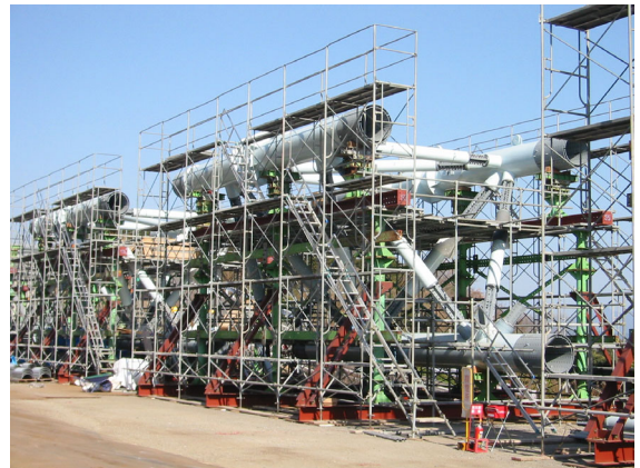
写真-13 地組立状況
