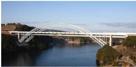
写真－1 新西海橋主橋部全景
