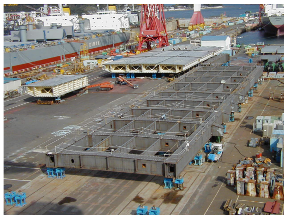
写真-7 補剛桁仮組立状況
