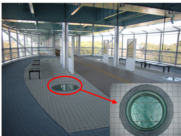
写真-3 添架歩道バルコニーと眺望ガラス
