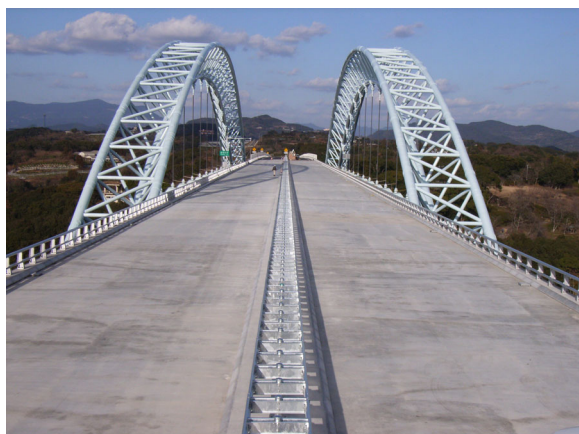
写真-2 橋面上の景観
