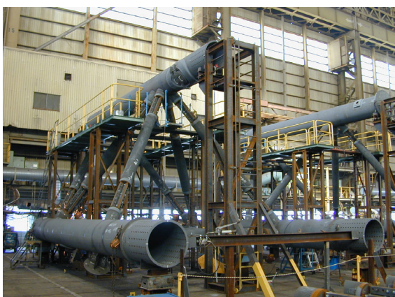
写真-5 アーチリブブロック組立状況
