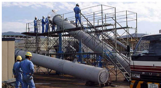
写真－10 コンクリート充填写真実施状況
