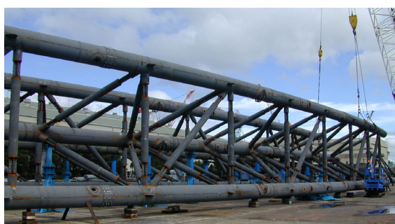
写真-6 アーチリブ仮組立状況
