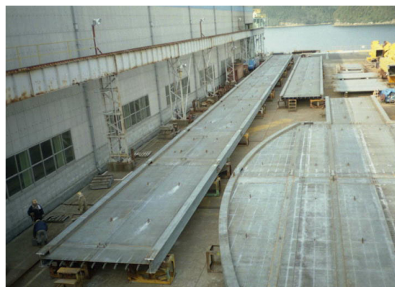
写真-8 添架歩道仮組立状況
