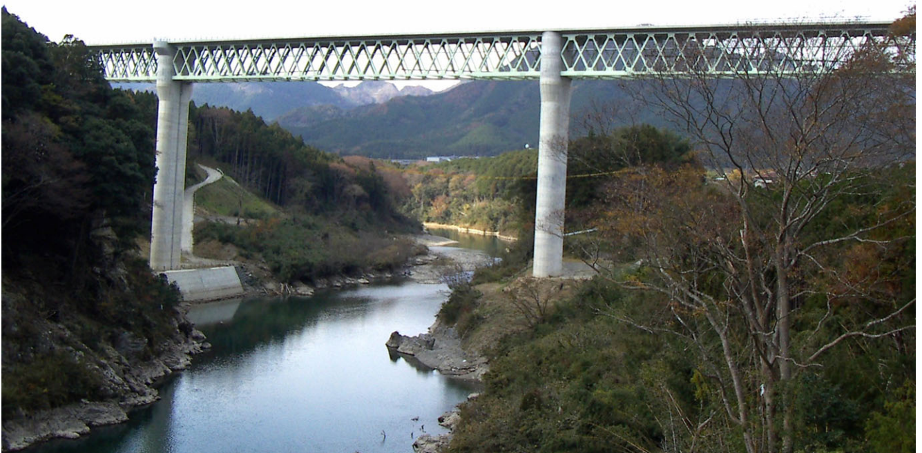
付一2:宮川下流より(左:P5橋脚, 右:P4橋脚)
