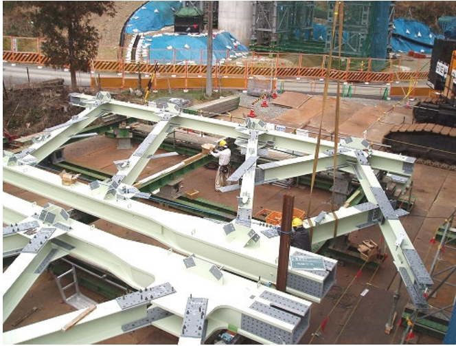
図-10 地組立状況
