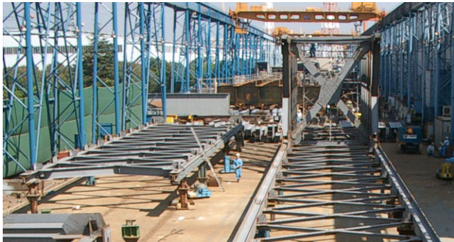
図-7 仮組み立て状況
