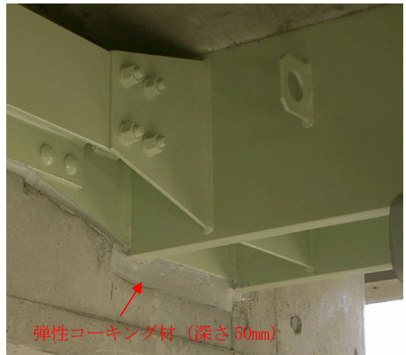
図-4 弦材突出部の弾性体によるコーキング
