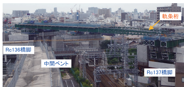
写真-4 軌条桁送出し
