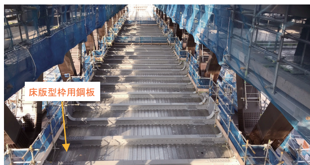
写真-6 床版型枠用鋼板
