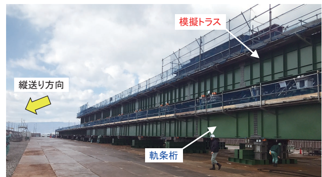
写真-2 トラス縦送り実証実験
