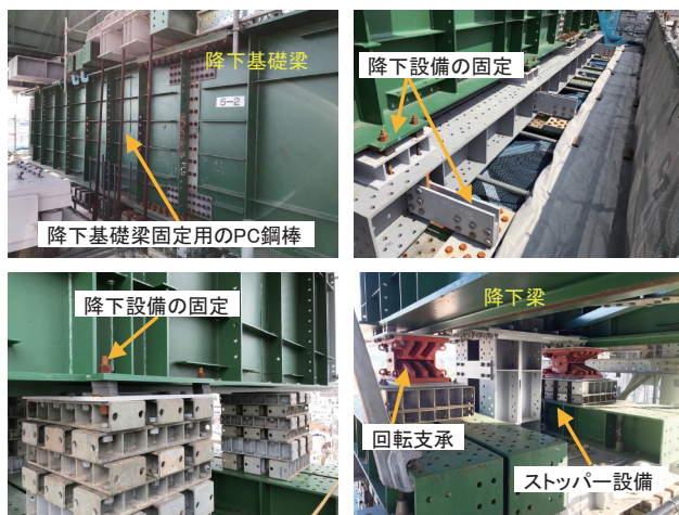
写真-10 降下設備の耐震対策
