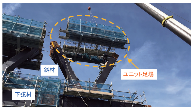
写真-5 トラス組立 ユニット足場
