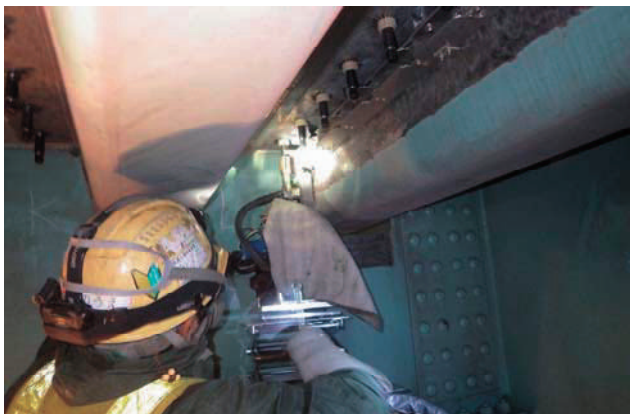
写真-1 スタッドボルト施工状況 (別工事)
