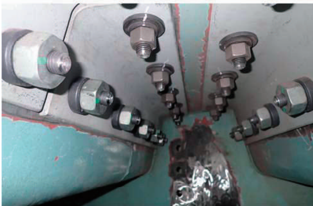
写真-2 当て板設置完了 (別工事)
