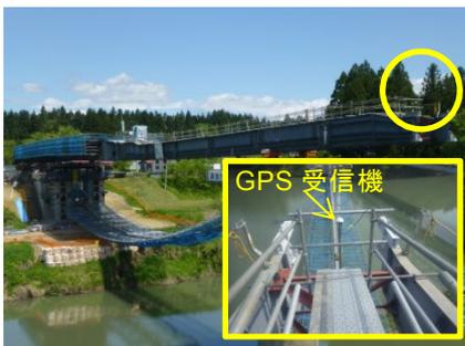
写真2 GPS 受信機設置写真
