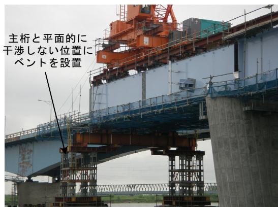
写真3 ベントと主桁の干渉回避
