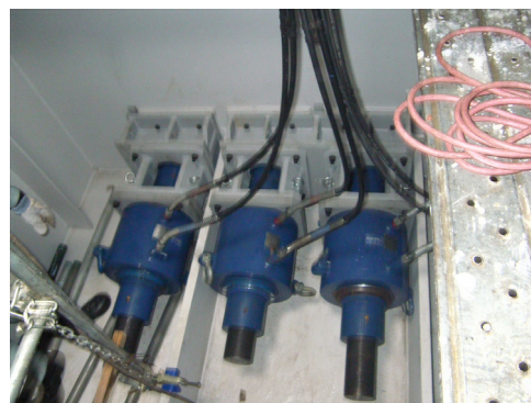
写真5 センターホールジャッキを用いた引込み治具
