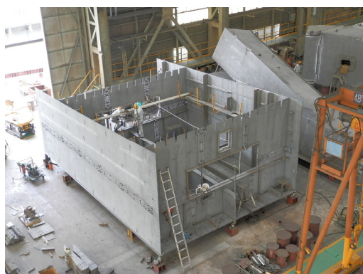
写真2 巨大ボックスでの組立・溶接作業
