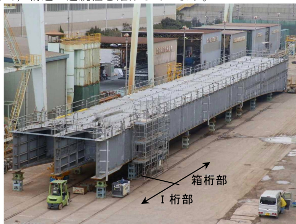
写真 1 3 主 I 桁-1 主箱桁接続部構造
