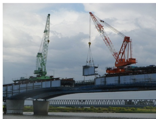
写真4 P7-P8 間の張出架設
