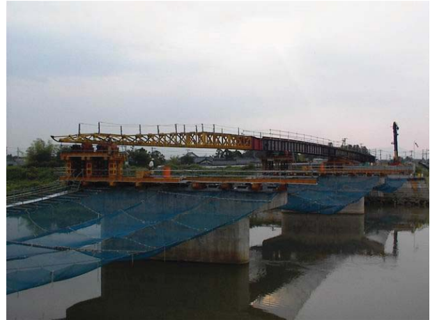
写真-2 送出し架設状況
