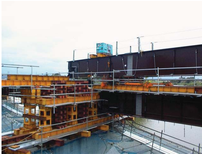
写真-5 横取り作業状況
