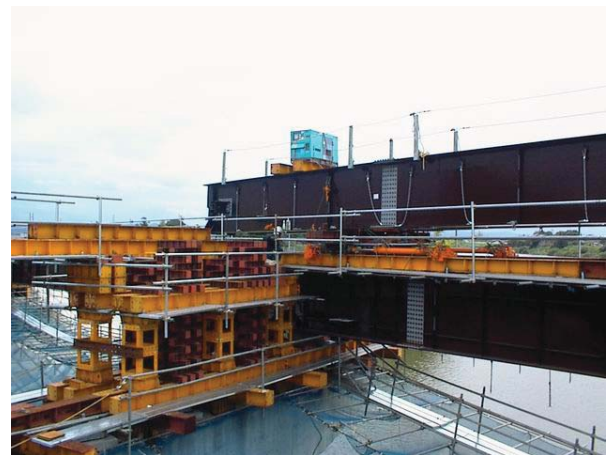
写真-3 縦送り架設状況
