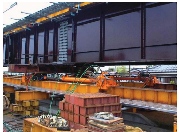
写真-4 送出し装置
