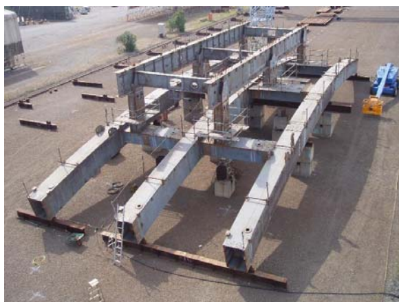
写真－6 重複仮組立
