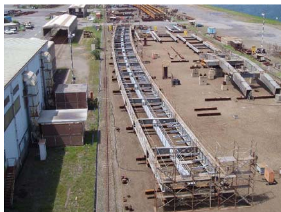
写真-4 補剛桁仮組立
