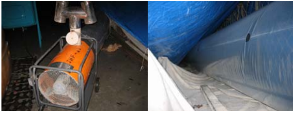
写真-13 寒中養生
