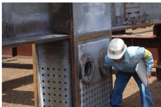
写真一 1 現場施工性確認
