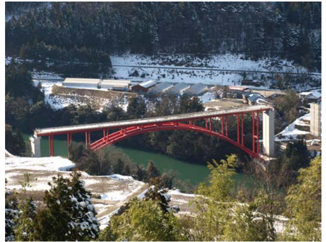
写真-15 完成写真②
