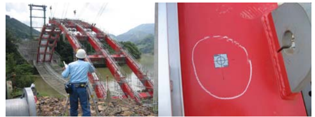
写真-11 出来形計測
