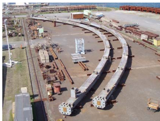
写真-5 アーチリブ仮組立
