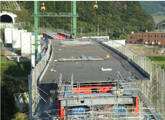
写真-9 合成床版架設状況
