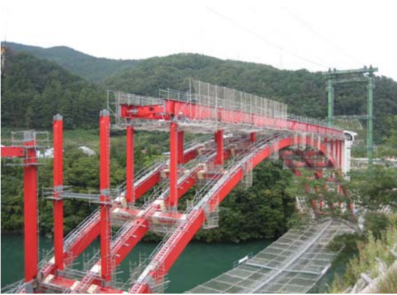
写真-8 垂直材・補剛桁架設状況
