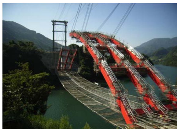
写真－7 アーチリブ架設状況
