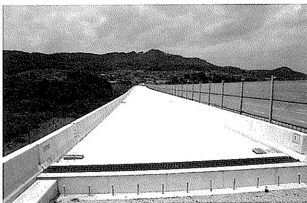
写真－56 壁高欄打設完了
