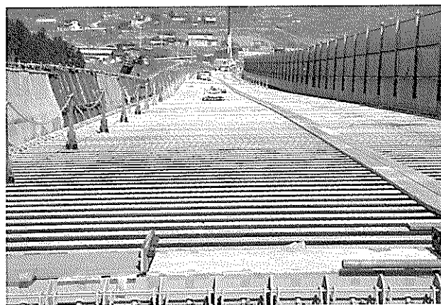
写真-32 合成床版架設完了
