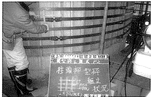
写真-2 木製型枠バンド施工状況
