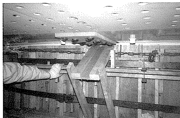
写真-4 スカートPLフロー状況
