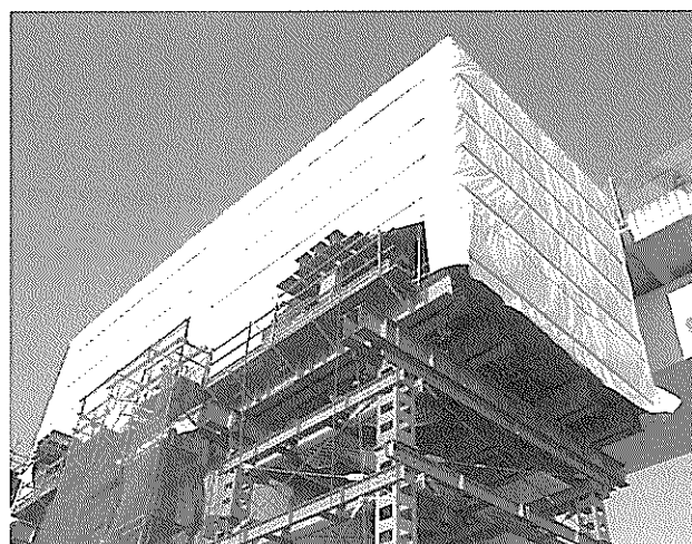
写真－9 養生枠組立完了
