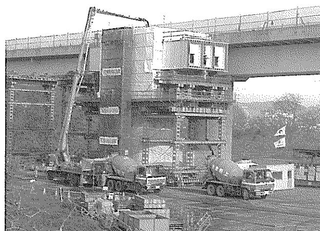
写真ー7 柱頭部高流動コンクリート打設状況
