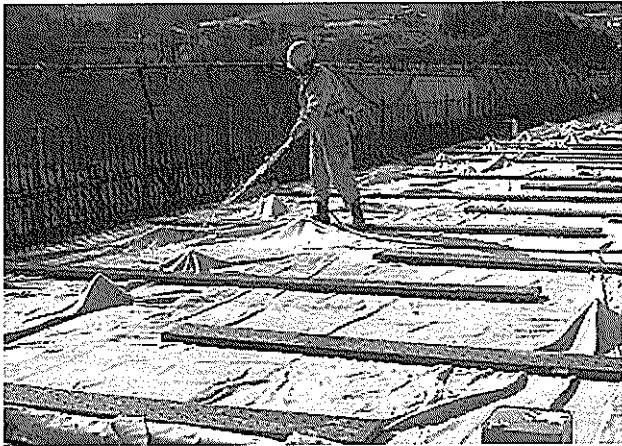
写真-47 養生マット敷設、散水養生
