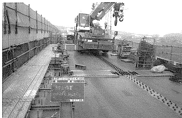
写真-19 添接部ゴムマット養生状況
