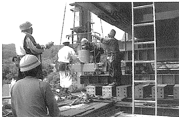
写真-18 送り装置撤去状況 (ジブクレーン)
