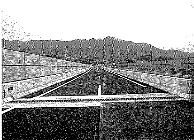
写真－57 工事完了
