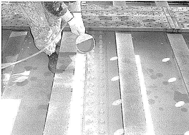
写真-37 マグネライン吹付状況
