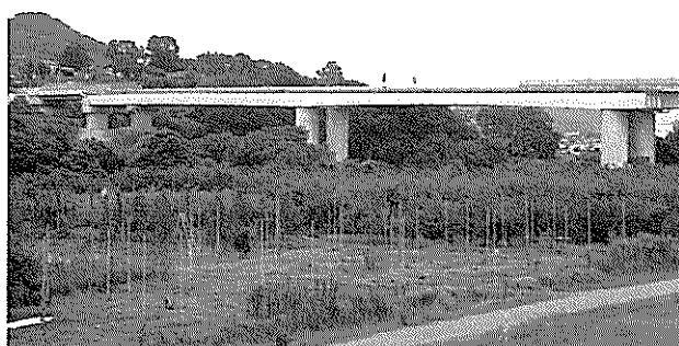
写真-22 第3,4径間(P2~P4)架設完了
