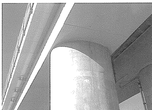
写真－11 高流動コンクリート打込み完了
