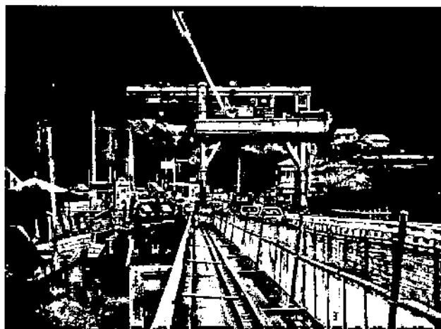
写真-2 門型クレーンによる架設状況
