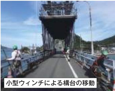
小型ウインチによる構台の移動
