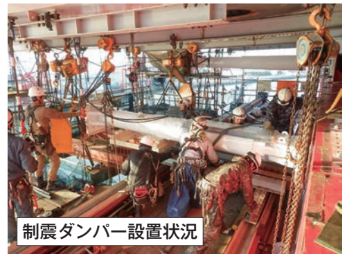
主塔部における耐震デバイスの配置
