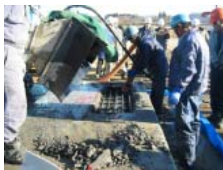
< 試験施工写真 >
