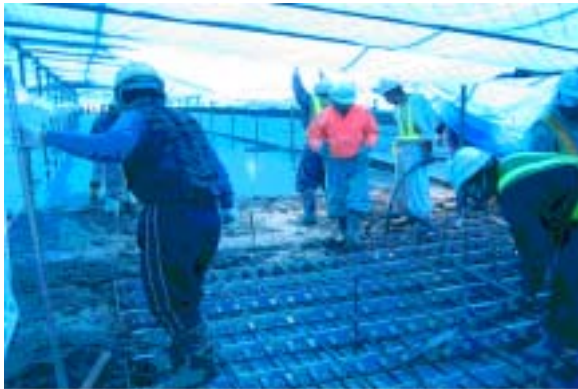
写真-1 給熱養生用上屋内での床版コンクリートの打込み作業
