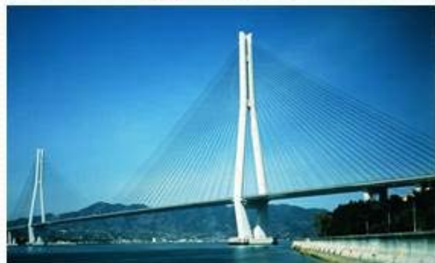
多々羅大橋
