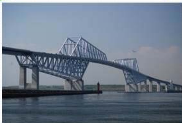
東京ゲートブリッジ
