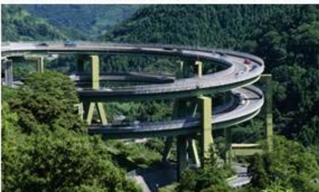
河津七滝ループ橋
