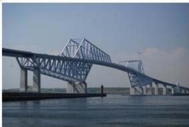
東京ゲートブリッジ
