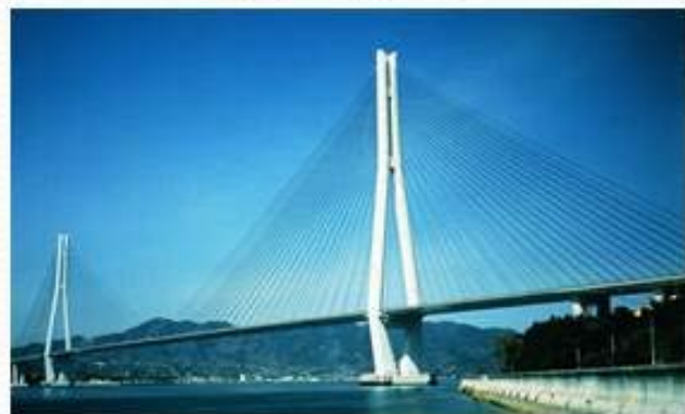
多々羅大橋
