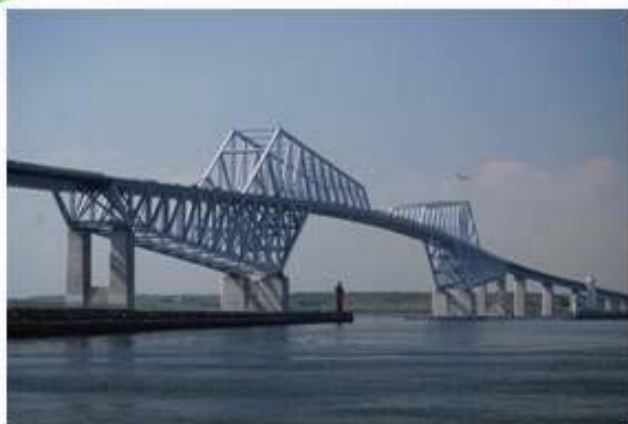
東京ゲートブリッジ
