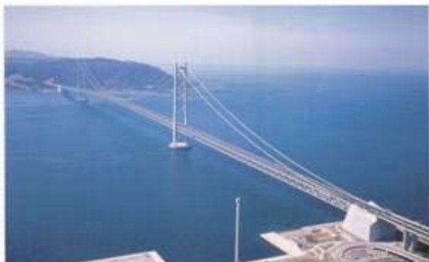
明石海峡大橋
