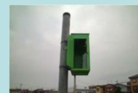
土研式タンクの支柱設置例
