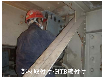
現場孔明・取付け・HTB締付け
