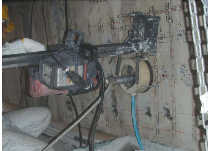
鉄筋センサーによる鉄筋切断の防止
