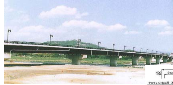
高知県・物部川橋 ・1994年竣工 ・4径間連続5主鈹桁2連 ・防食：耐候性無塗装 ・RC床版
