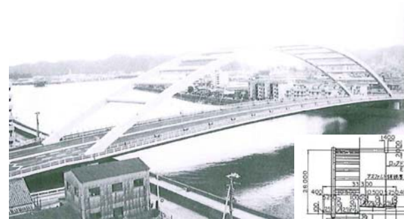
高知県・鏡川大橋 ・1980年竣工 ・ニールセン ・防食：塗装 ・鋼床版
