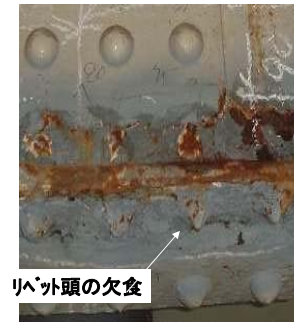
腐食リベットの取替えによる水の浸入
