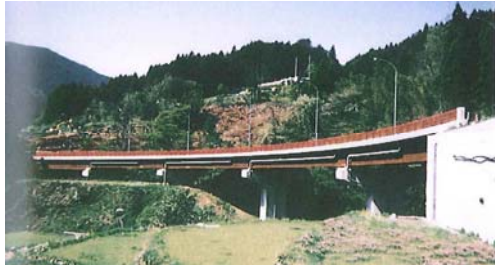
高知県・小申田橋 ・1996年竣工 ・4径間連続4主鈹桁 ・防食：耐候性無塗装 ・RC床版
