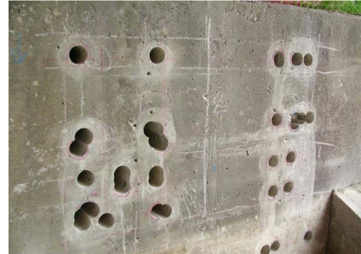
孔埋め作業も発生する
