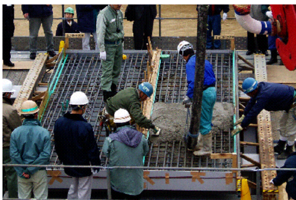
写真-3 施工試験の実施状況
