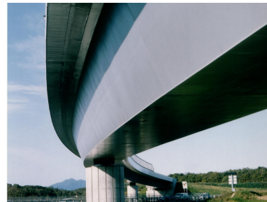
写真-2 千歳ジャンクション・Cランプ橋 日本道路公団(当時) 1998年竣工
