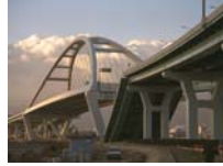
西宮港大橋 (1995.1) 兵庫県南部地震
