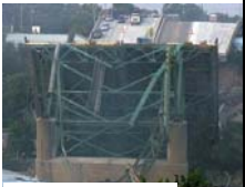
鋼トラス橋の崩壊事故 (米国ミネソタ州・2007)
