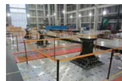
基準橋脚設置
