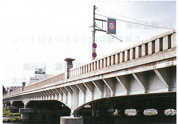
写真—4 賀茂大橋
