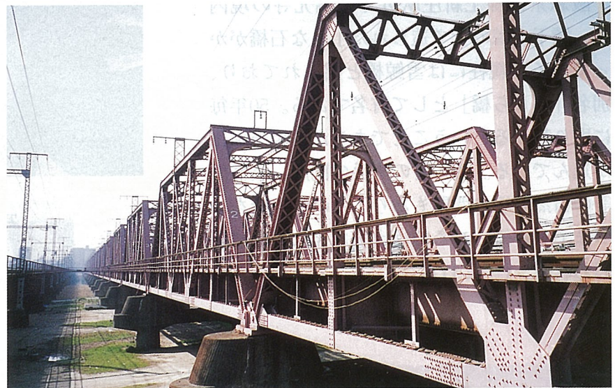
東海道線上淀川橋梁
