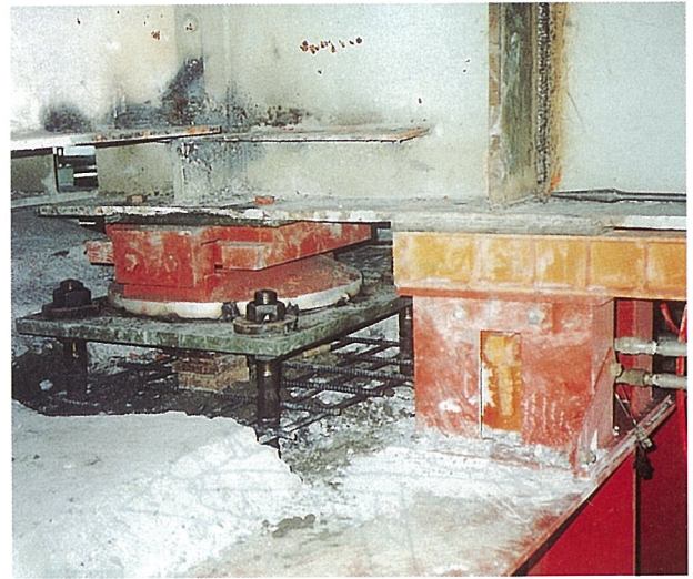
写真-1 組合せジャッキによる仮受
