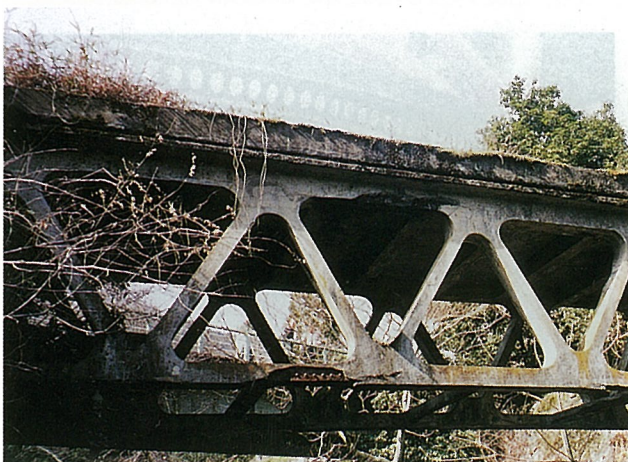
写真—3 二の瀬橋
