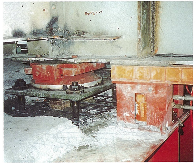
写真-1 組合せジャッキによる仮受
