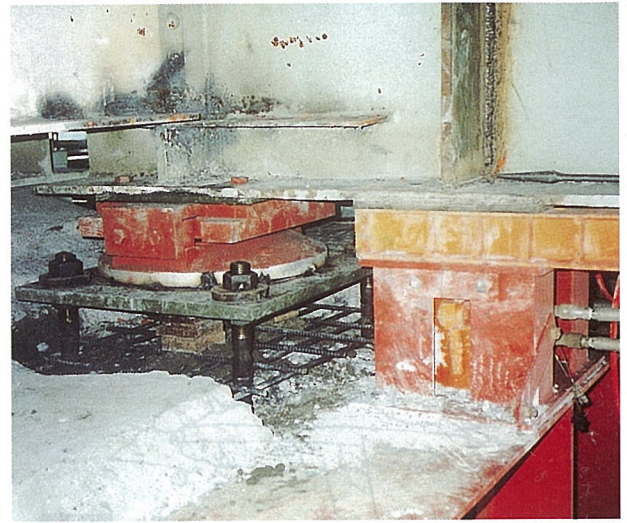
写真-1 組合せジャッキによる仮受
