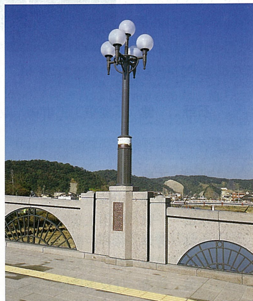
親柱：あたたかい重厚な品格を備えた薩摩焼を橋名板と照明灯の飾り枠に用いました。
