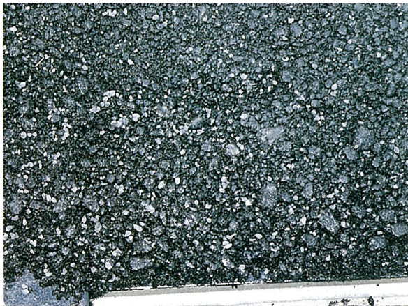
写真-11 改良型アスファルト舗装
