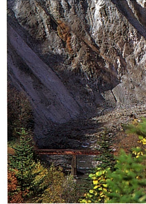
夕張岳の名所、蛇紋岩地帯に架かる橋梁。釧路工機部払下げ版桁と 思われる。
