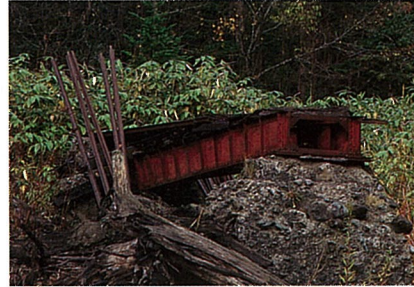
地図5地点付近に点在する釧路工機部払下げ版桁であるが昭和25年横河橋梁製と記した銘板がついている。
