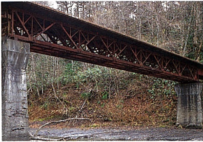
地図3地点にあるJKT。支間20mのタイプである。 1996.11
