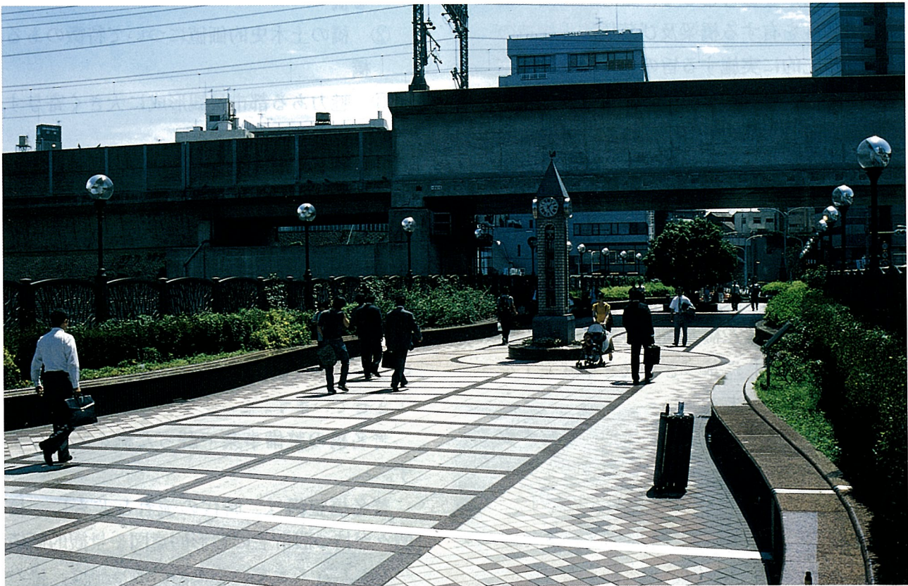
写真-34 田端ふれあい橋
