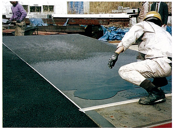
写真-13 薄層舗装（ニート工法）
