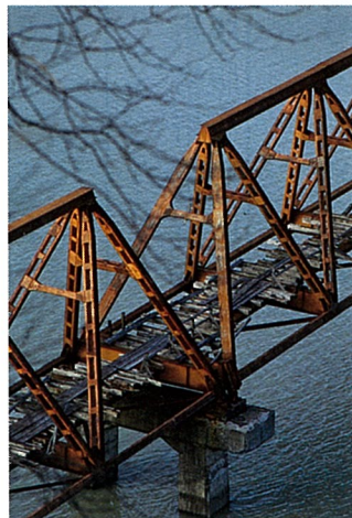
四角錘を並べた美しい三弦橋の構造 1992.5
