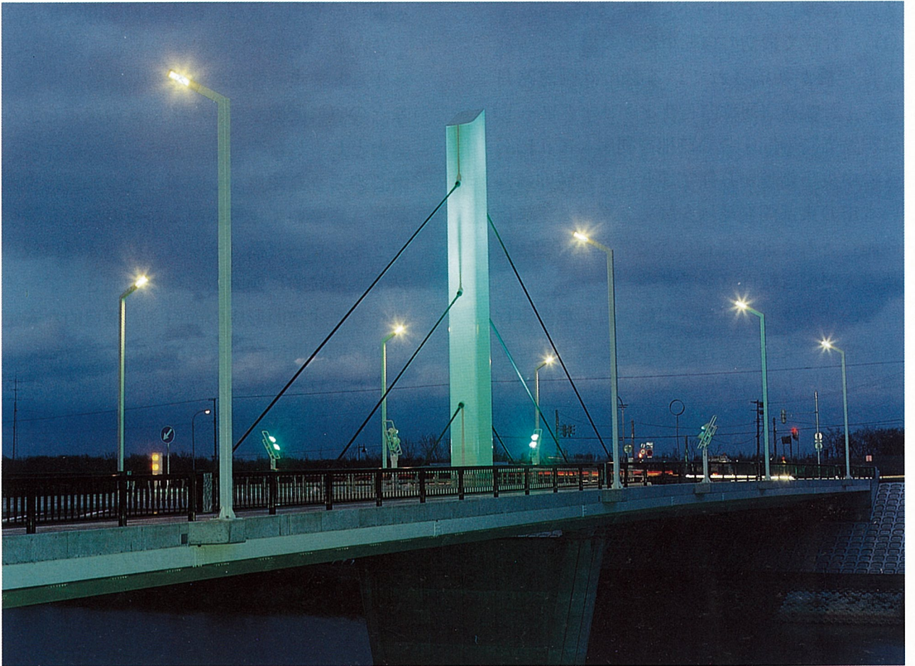
写真-19 「前田森林公園橋」
