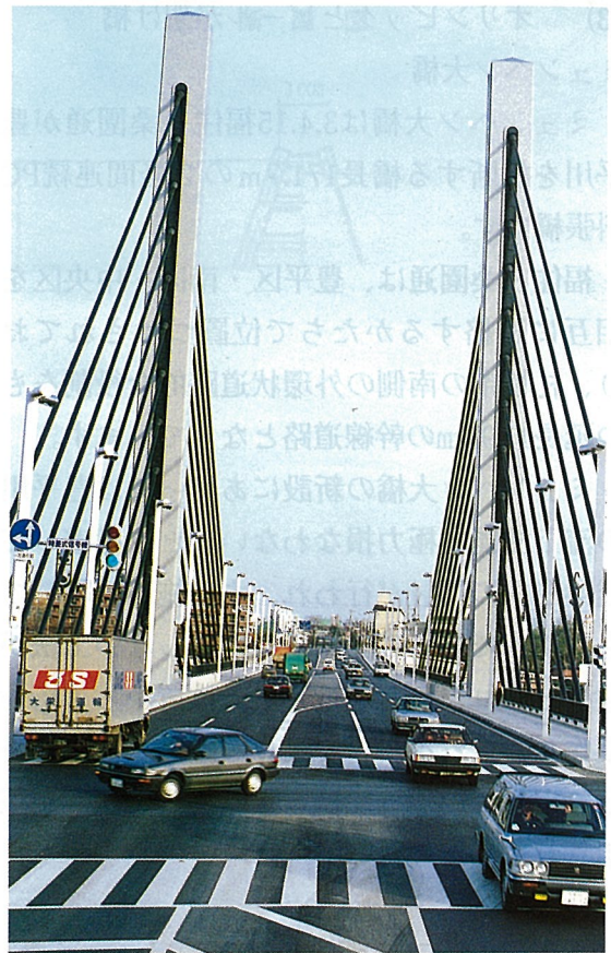
写真-9 ランドマークとなる主塔
