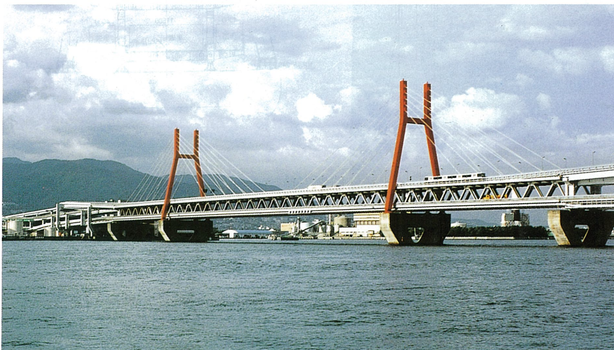
写真-3 六甲大橋
