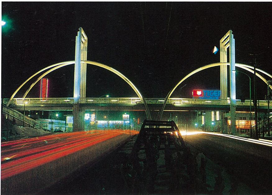
写真-22 ライトアップがまぶしい「環状夢の橋」
