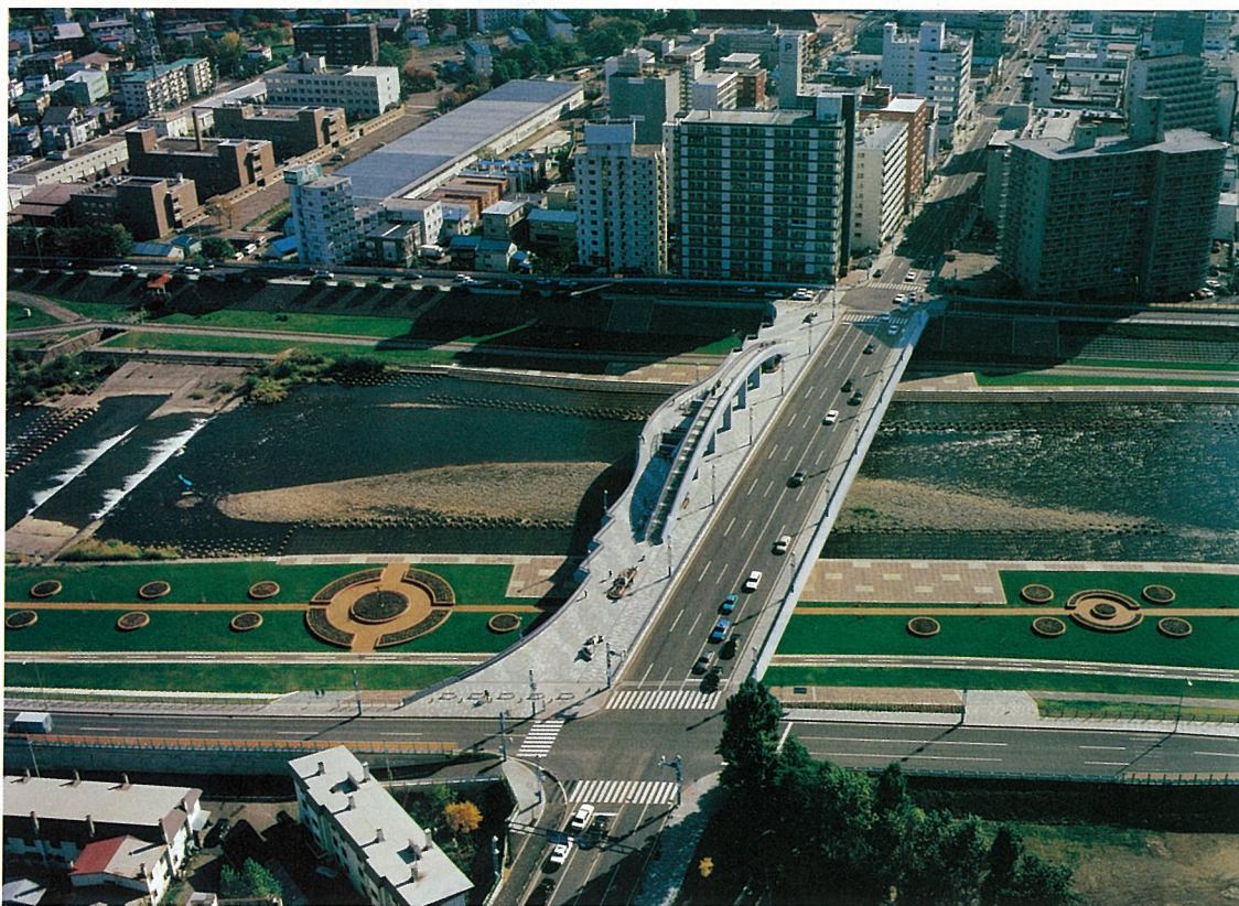
写真一 2 都市と市民を育てる橋「新幌平橋」
