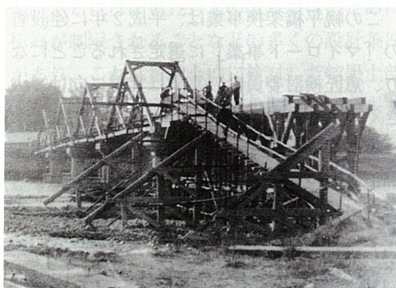
写真-3 建設中の初代幌平橋
