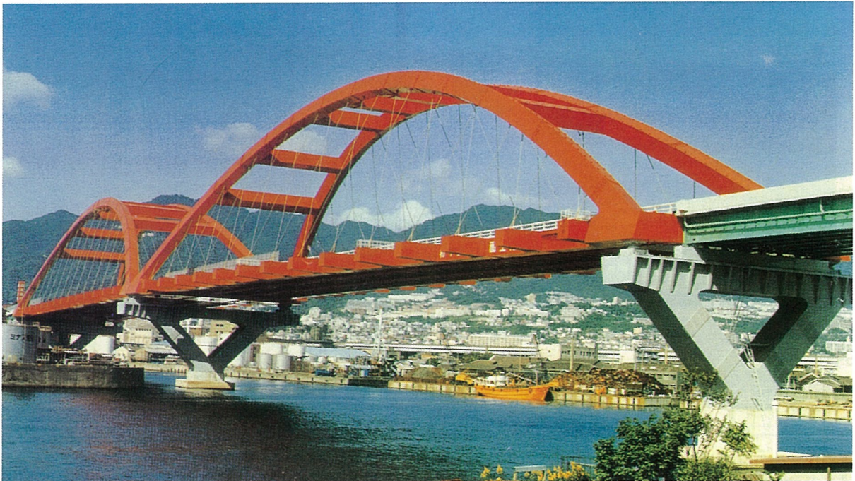
写真一 5 灘大橋
