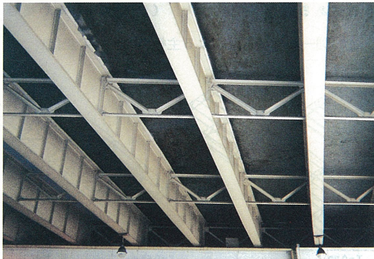
写真-1 都市内高架橋における施工例
