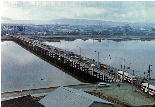
我が国初の合成桁・神崎橋（昭和28年架設）
