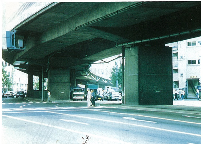
写真-1 目黒架道橋
