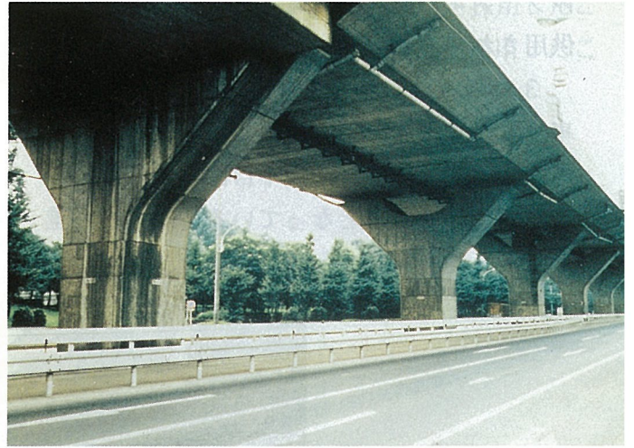
写真－3 高島平高架橋
