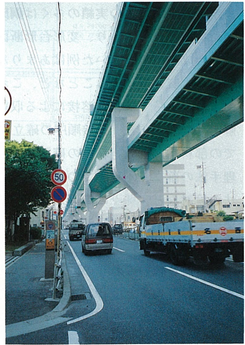
写真-8 清水高架橋
