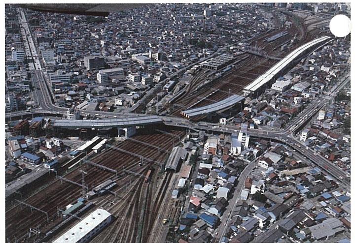
写真-5 黄金高架橋押し出し架設
