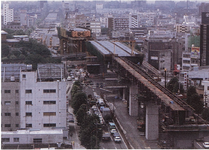
写真一 2 押し出し架設
