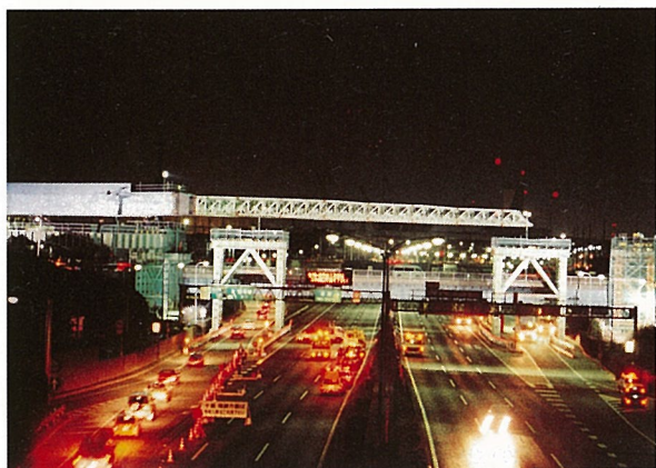
写-13 首都高速湾岸線上桁架設状況 道路両脇の門型がシェルター、桁架設時はこの中に車両を誘導した。
