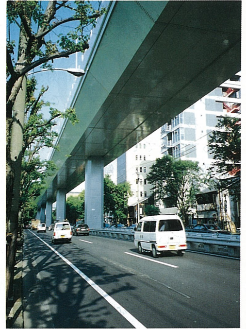
写真-12 分岐2号高架橋点
