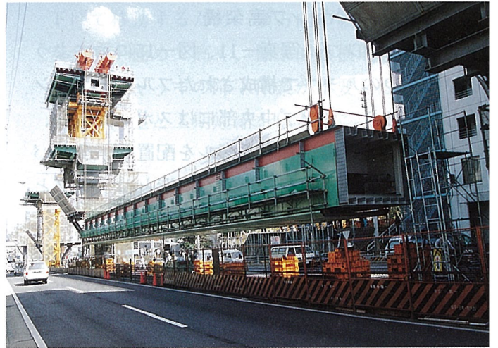
写真-10 一括吊り上げ架設
