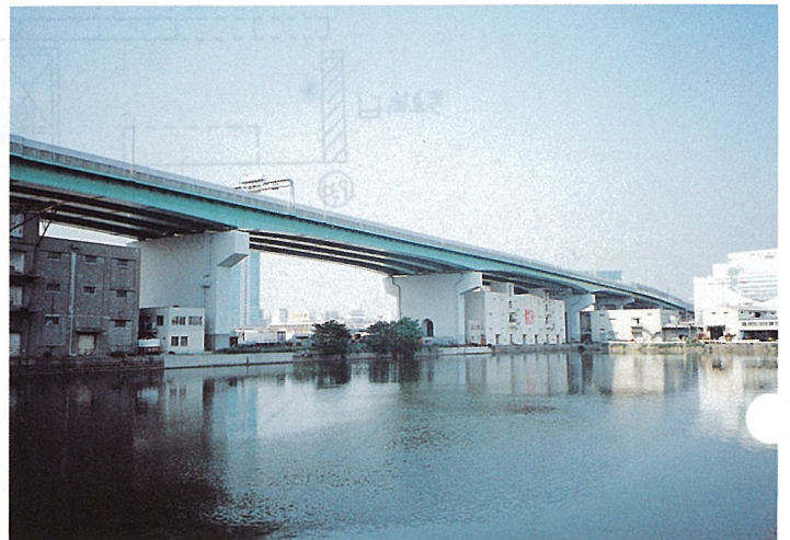
写真一 3 運河工区高架橋
