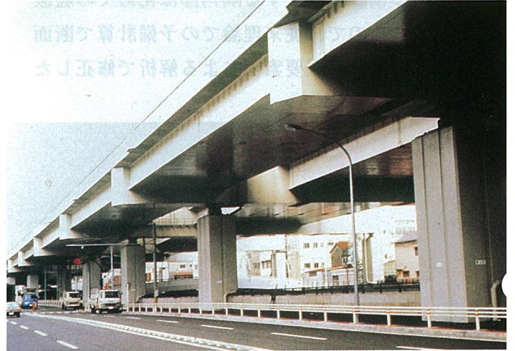
写真一 6 堀川筋高架橋
