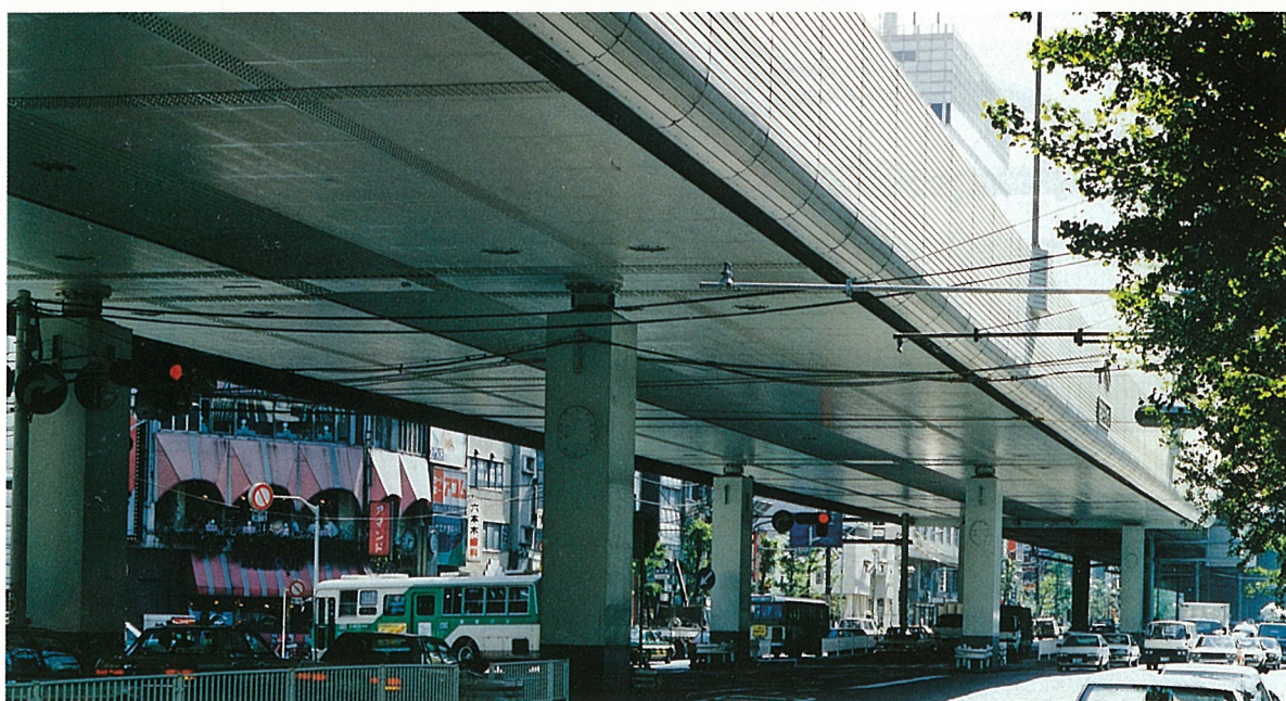
写真一15 六本木交差点高架橋
