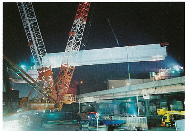
写-8 首都高速都心環状線上桁架設状況 中央の橋梁が首都高速都心環状線。
