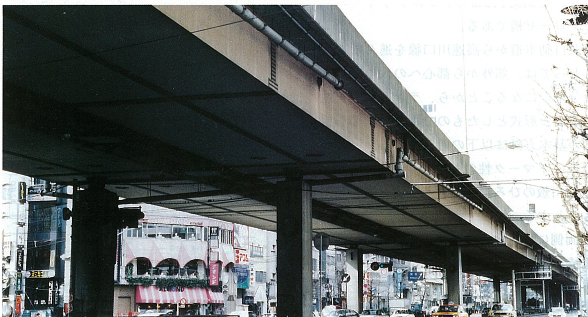
写真一14 六本木交差点高架橋
