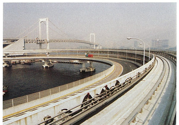
写-11 レインボーブリッジループ部
