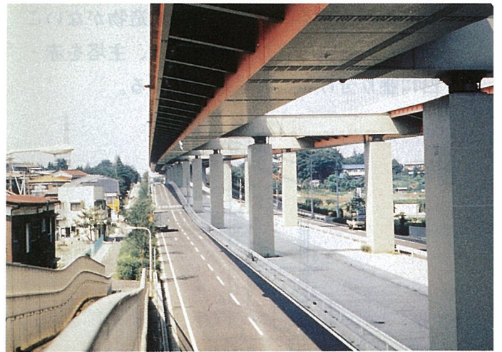
写真－9 本郷高架橋
