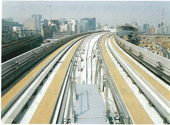
写-4 橋面（汐留付近）
