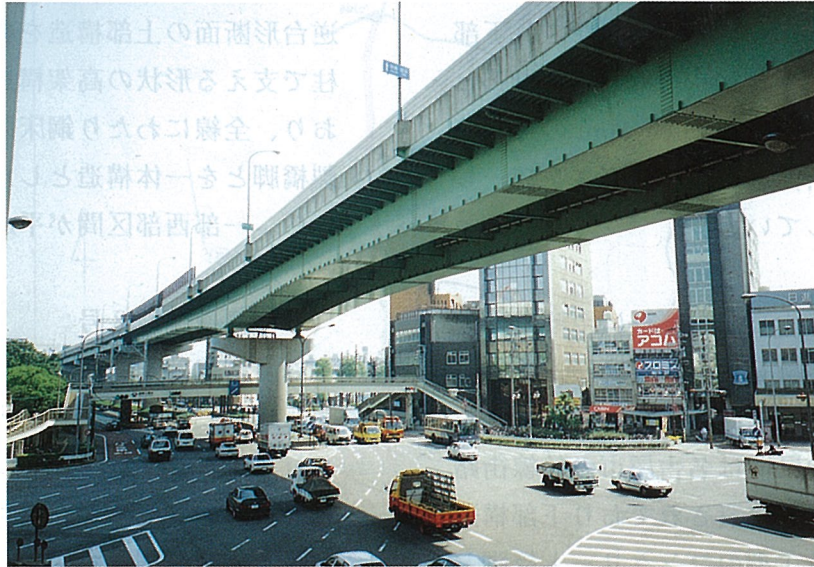
写真-1 鶴舞高架橋
