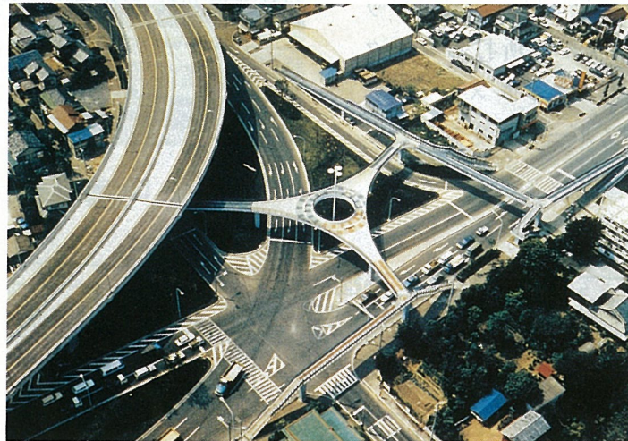
写真一 4 蓮根歩道橋
