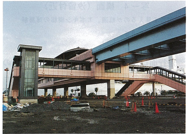
写－6 駅連絡通路
