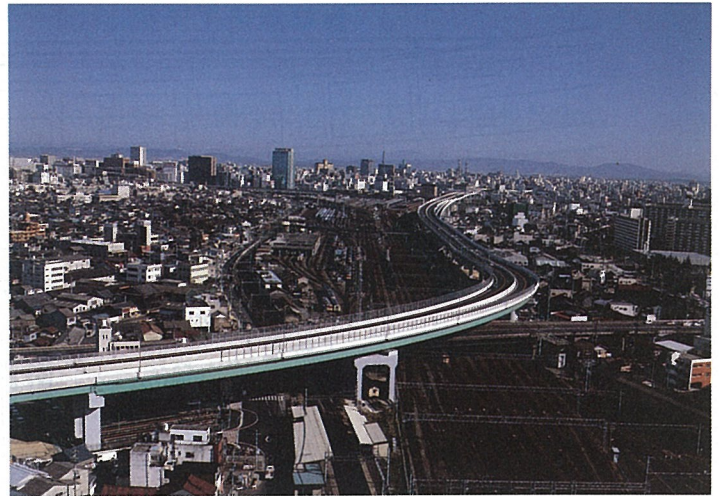
写真-4 黄金高架橋
