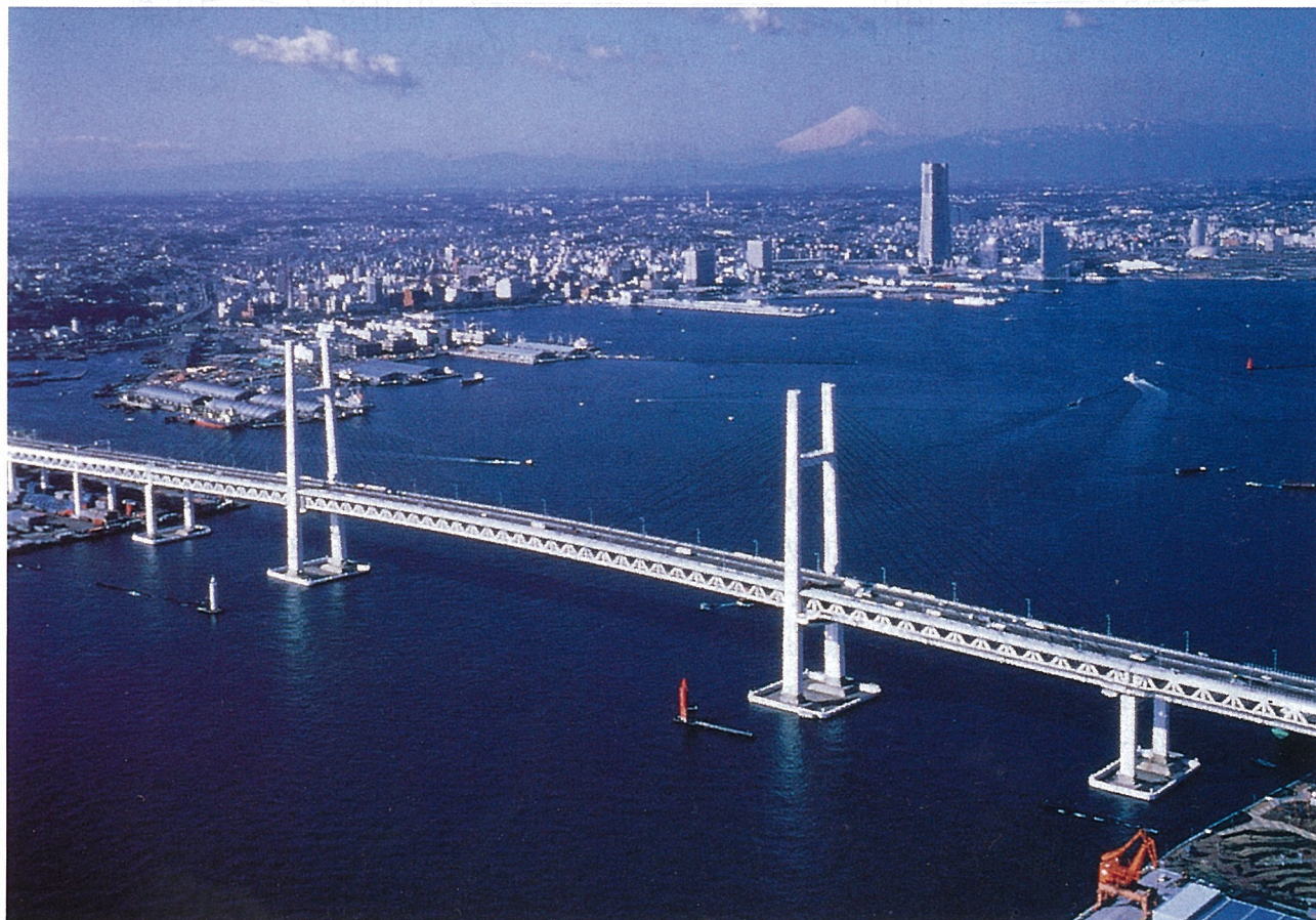
写真-10 横浜ベイブリッジ
