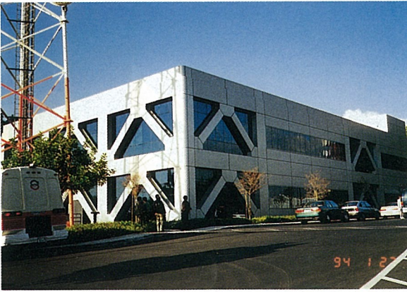
免震ビル： Fire Command Control Bldg. (積層ゴム支承16個設置)
