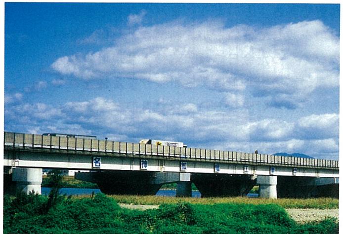
名神改築（桂川大橋）
