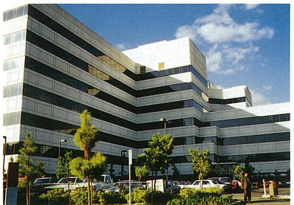
免震ビル：USC University Hospital（8階建） (ゴム支承が平面輪かく線に沿って87個設 置されている)
