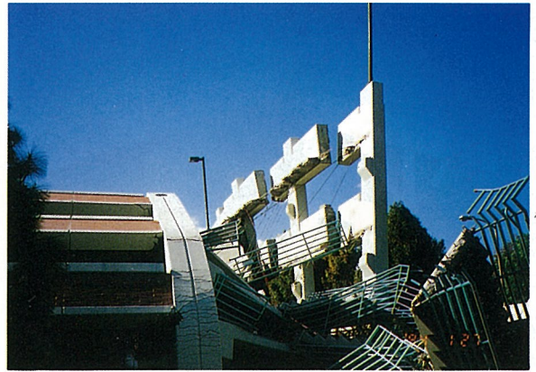
California State University Northridge 校 の立体駐車場の崩壊
