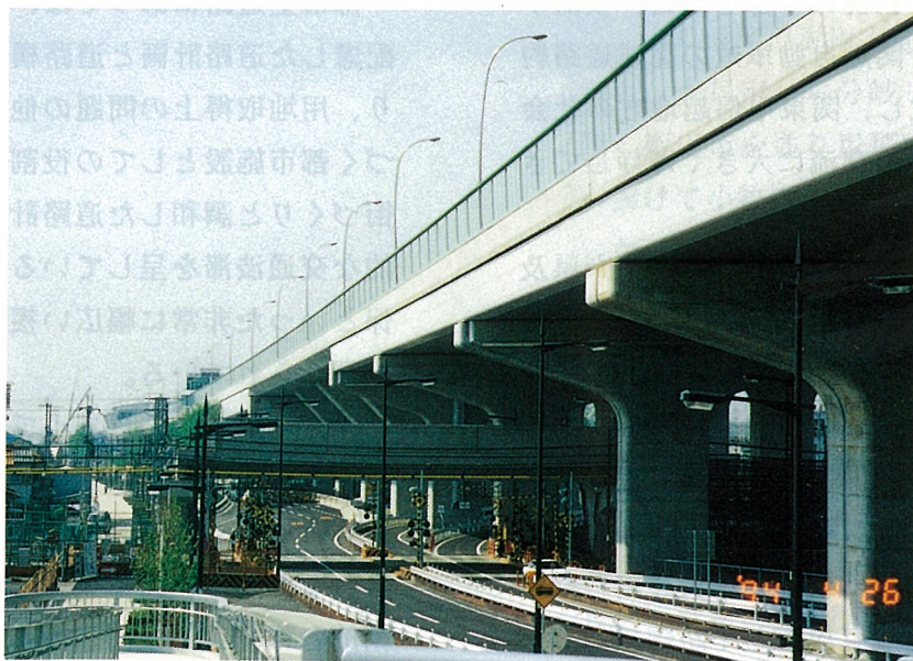
関西国際空港線（末広高架橋）
