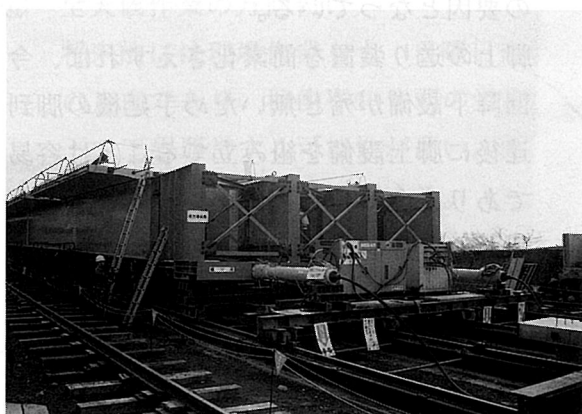
送り出し推力設備
