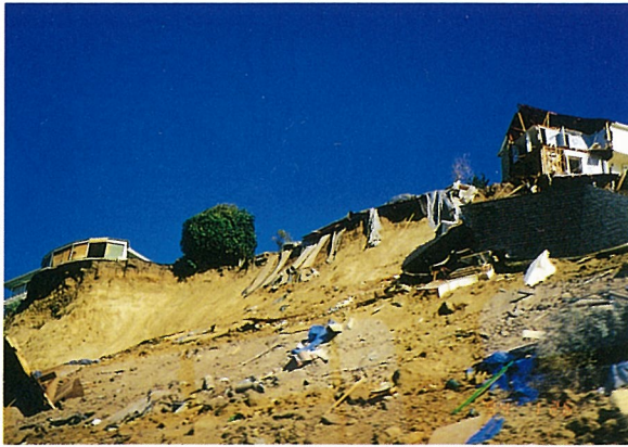
サンタモニカ地区のがけくずれ (海岸沿い、崖上の家屋が倒壊している)
