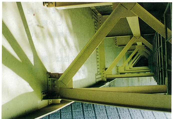
引張りボルト接合 (桂川大橋)
