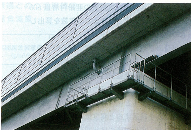
溶融亜鉛めつき橋の追跡調査 (立部第二高架橋)
