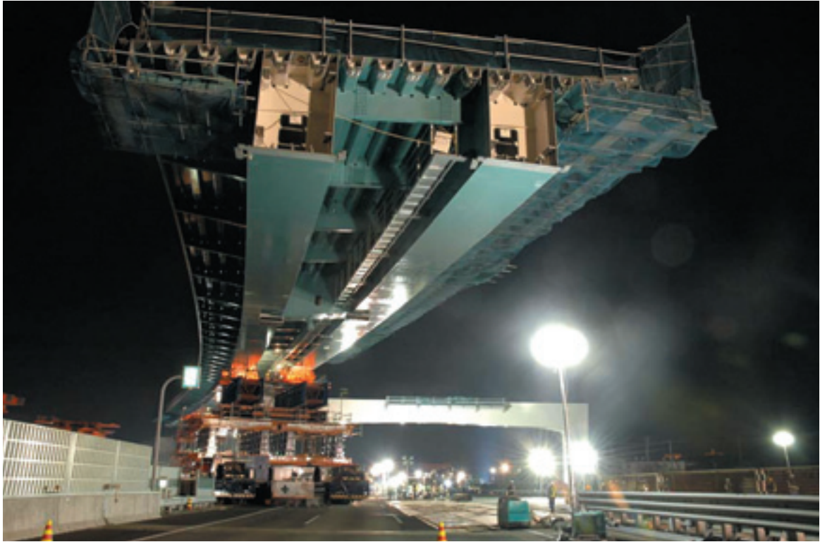
東名本線進入中の鋼桁大ブロック
