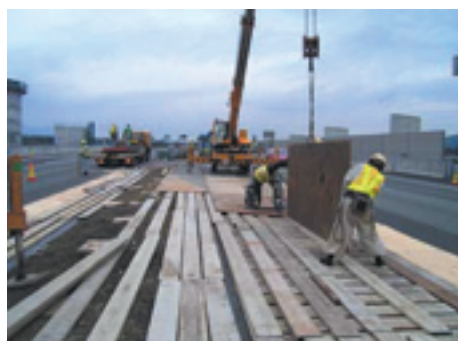
スロープ設置状況
