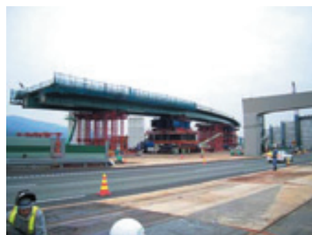
スロープと搬送を待つ鋼桁
