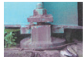
県道新潟寺泊柏崎線枇杷島跨線橋
