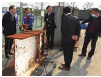
⑤ 損傷橋梁の見学
