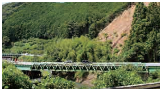
南部川仮橋2号橋
