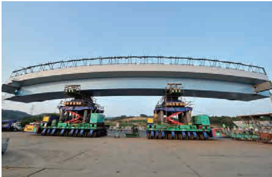
多軸式自走台車と橋桁ブロック
