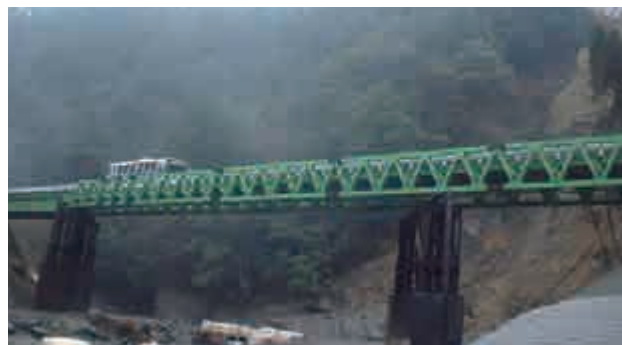
R388災害復旧仮橋
