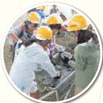
▲コンクリート 練り混ぜ体験！
