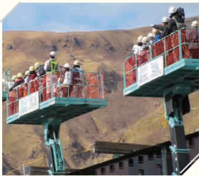
▲高所作業車に乗って架設の様子を見学。
