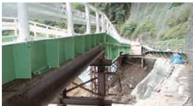
南アルプス公園線仮橋
