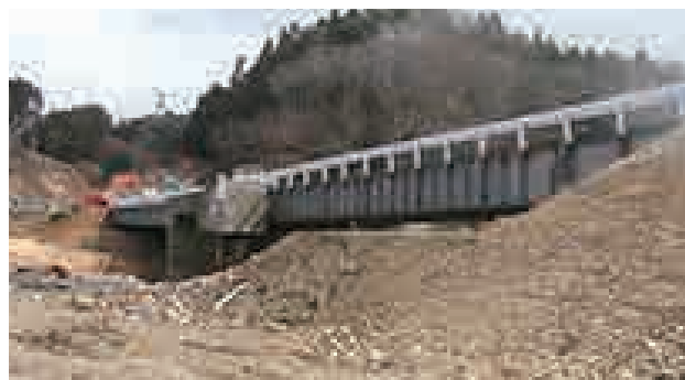
国道45号二十一浜応急復旧仮橋
