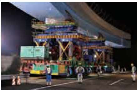
多軸式自走台車と橋桁ブロック
