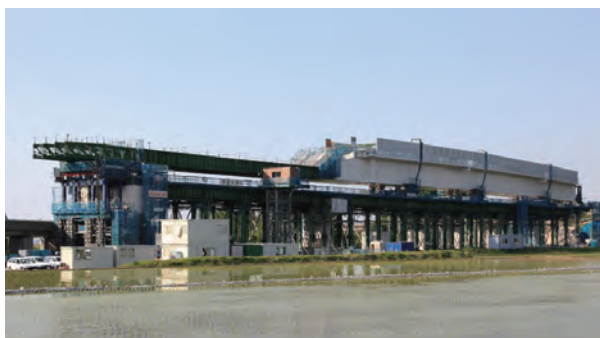
送り出し架設前
