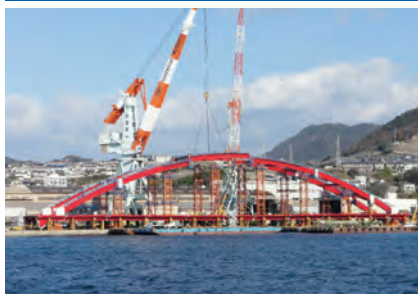
工場地組状況
