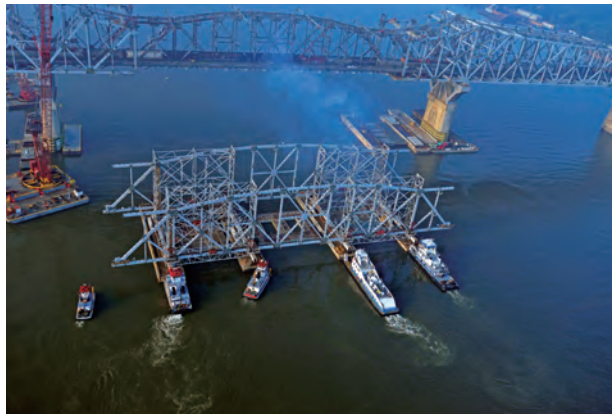
図-7 大ブロック曳航状況 (中央径間ブロック架設時)
