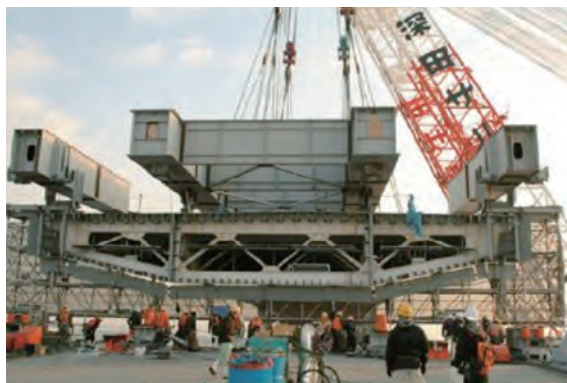
写真-17 大ブロック(中央部)架設状況
