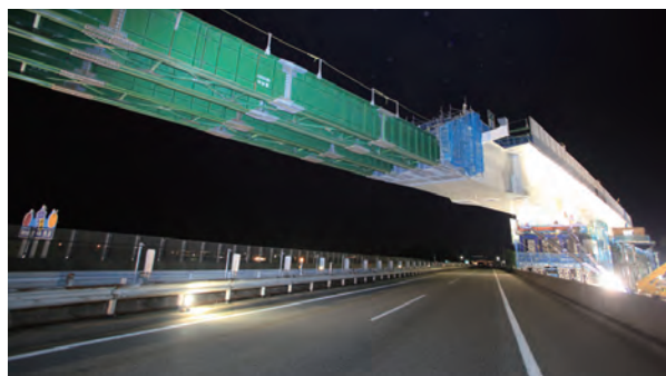
送り出し架設（1日目）
