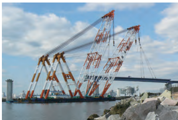
写真-20 大ブロック(アプローチ部)架設状況
