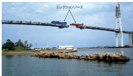
移動防護工を利用したフェアリングの設置
