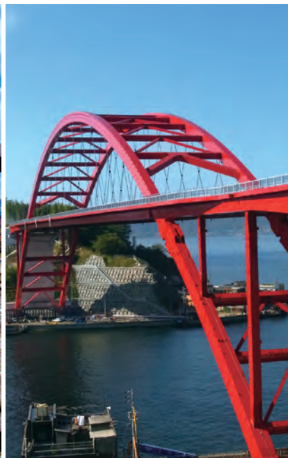
第2音戸大橋完成写真
