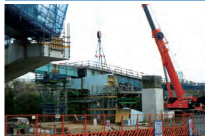
主桁の改造（桁端部）
