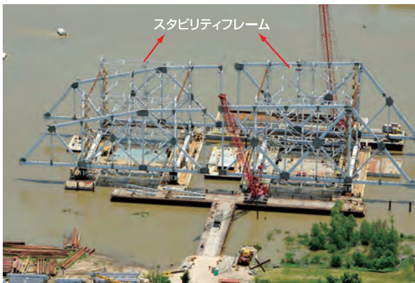
図-6 水上地組み状況（閉合作業前）
