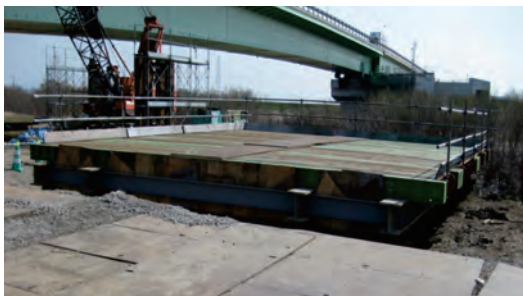
クレーン構台設置状況
