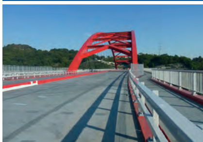
完成時の橋面
