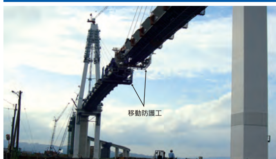
移動防護工を利用したフェアリングの設置
