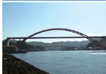
第2音戸大橋と音戸大橋
