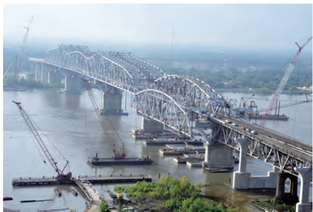
図-9 単径間ブロック吊上げ
