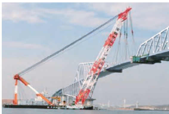
写真-18 大ブロック(中央部)架設状況
