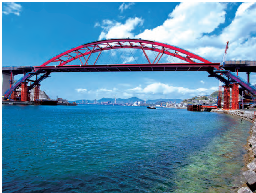
一括架設直後(アーチ中央に補強ベントが設置されている)
