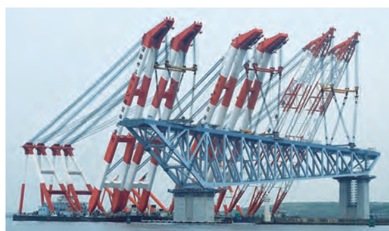
写真-6 大ブロック架設状況
