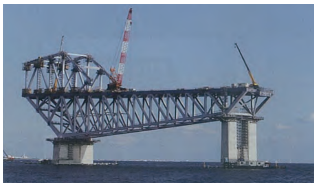
写真-12 上部トラス架設状況
