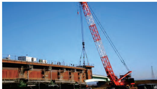
500t吊クローラークレーンによる桁架設状況
