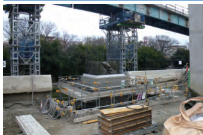
主桁の増設（幅員変更）
