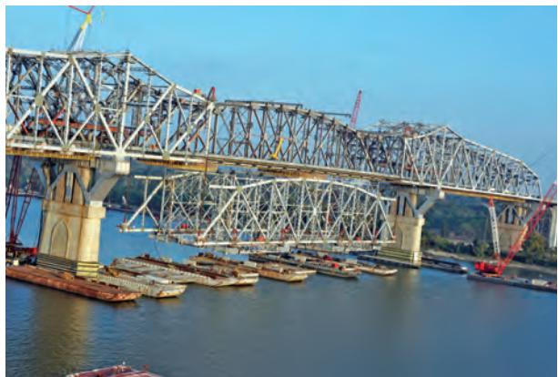
図-8 中央径間ブロック吊上げ
