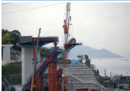
音戸側陸上ブロックの架設
