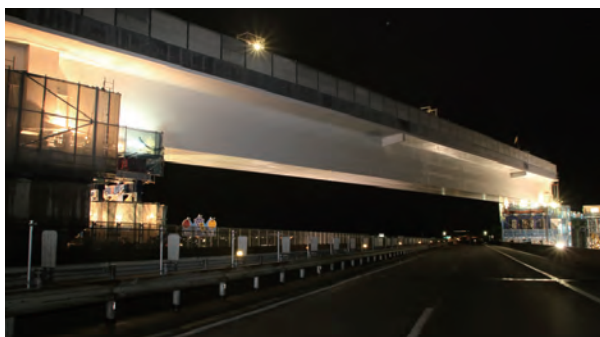
送り出し架設（2日目）
