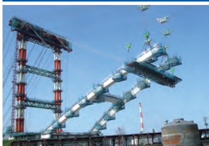
アーチリブ斜吊架設状況
