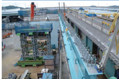
主桁の増設（幅員変更）
