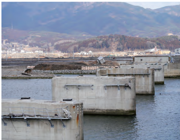
気仙大橋。津波で橋桁は流失した。残った橋脚のとなりに仮設橋が架けられている。(H24.2.24撮影)
