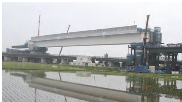
送り出し架設完了
