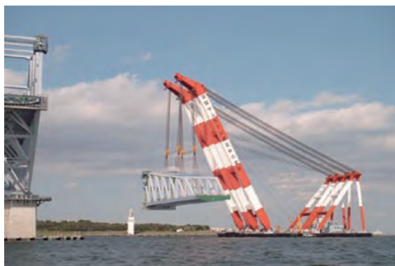
写真-15 架設前日の吊り切り状況
