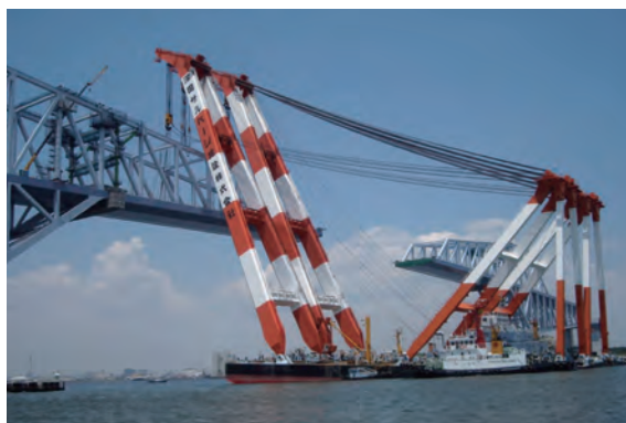
写真-16 大ブロック架設状況
