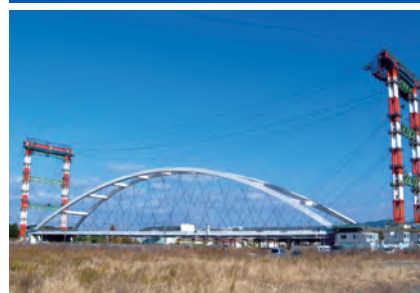
補剛桁閉合完了
