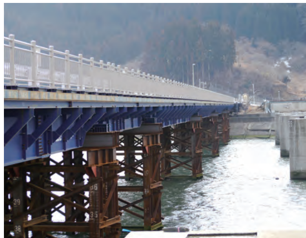
気仙大橋。津波で橋桁は流失した。残った橋脚のとなりに仮設橋が架けられている。(H24.2.24撮影)
