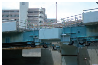
主桁の改造（桁端部）
