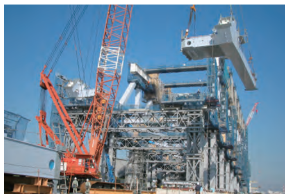
写真-1 地組立状況（下弦材地組立）
