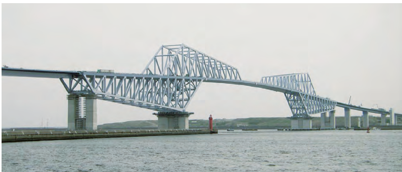
写真-22 架設が完了した地上からの東京ゲートブリッジ
