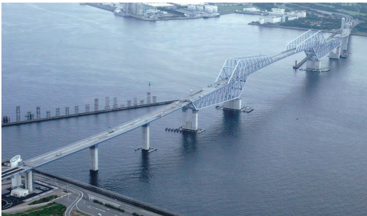
写真-21 架設が完了した上空からの東京ゲートブリッジ
