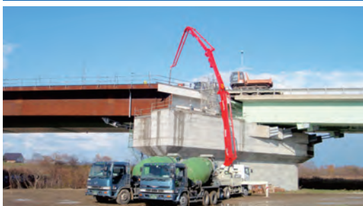
桁端カウンターコンクリート打設状況
