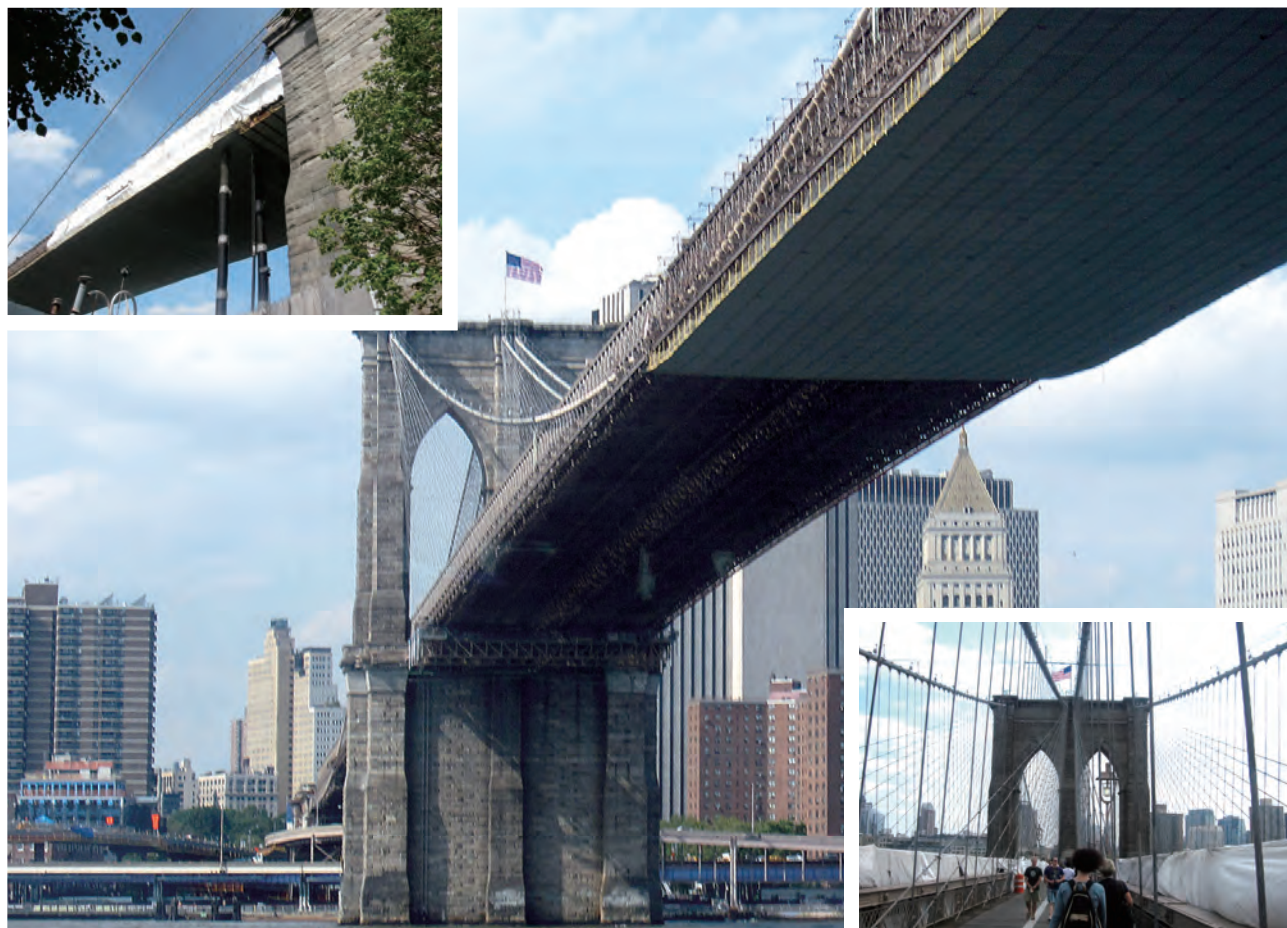
写真-1 塗替え塗装中のブルックリン橋
