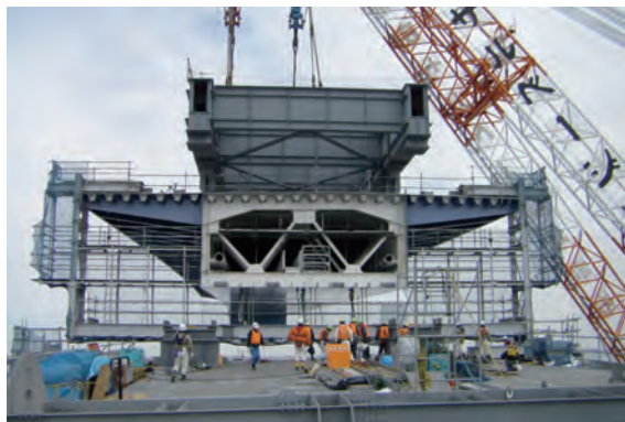
写真-19 大ブロック(アプローチ部)架設状況
