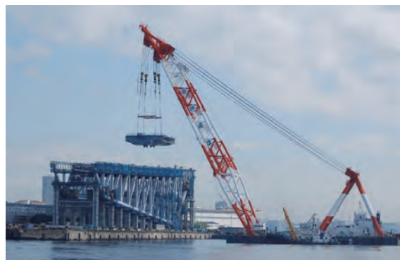
写真-2 鋼床版ブロック架設状況
